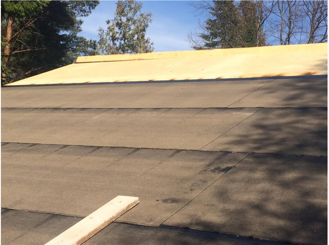
KUVA 10. Tasainen ja ääntä eristävä alusta konesaumakatolle
