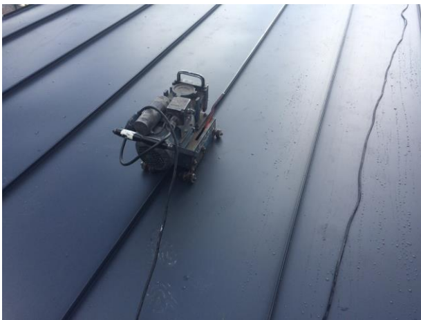
KUVA 16. Saumaus sähkökoneella
