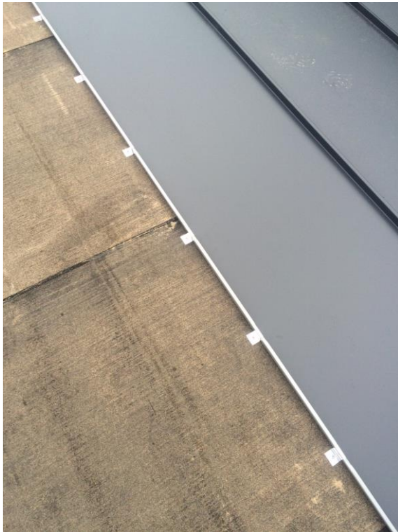
KUVA 12. Kiinnikejako keskikaton osalla
