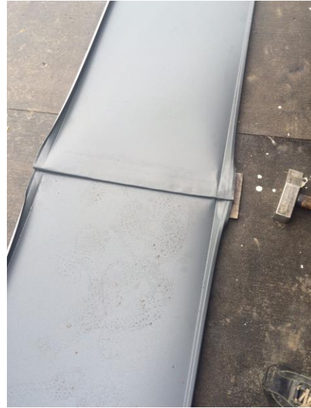
KUVA 21. Pellinpäät yhteen
