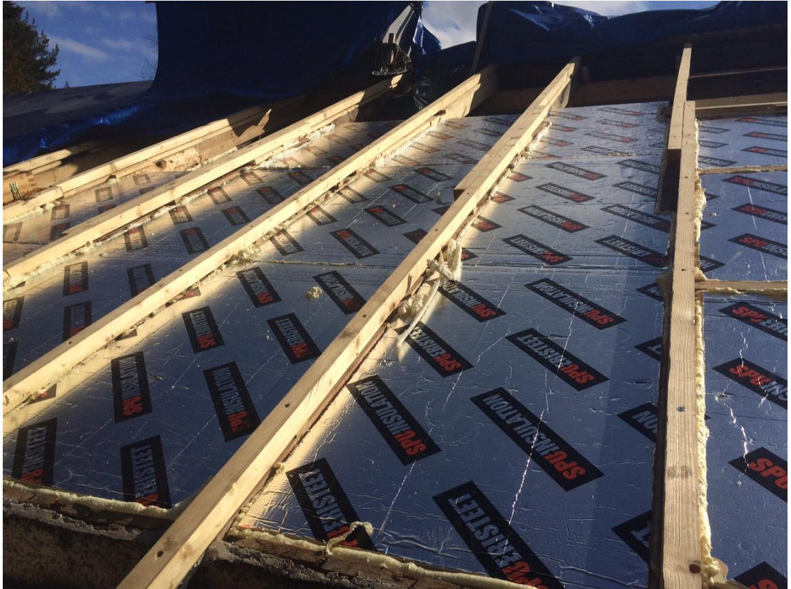
KUVA 7. Yläpohjan uusittu eriste
