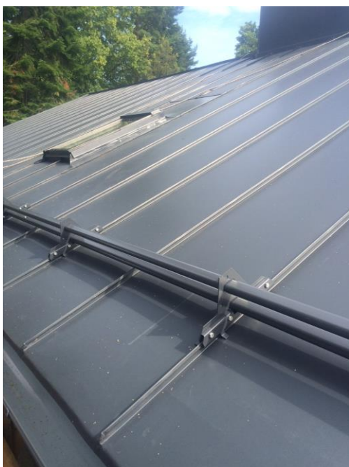
KUVA 24. Lumieste kiinnitettynä
