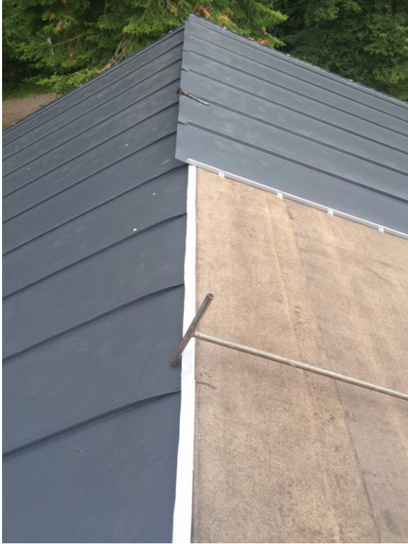
KUVA 14. Peltirivien asennusta
