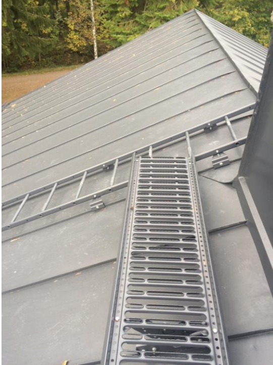
KUVA 26. Kattosilta
