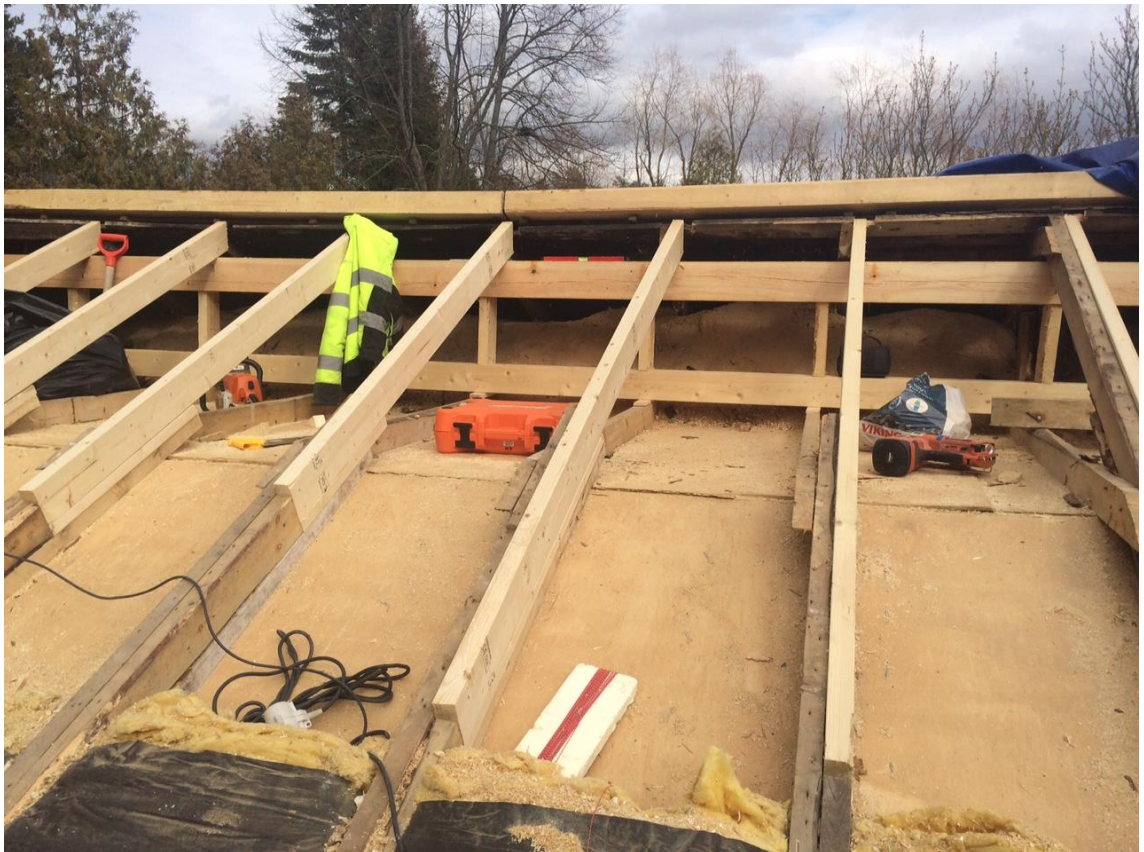
KUVA 4. Kattokannakkeet vanhaa rakennetta uusien
