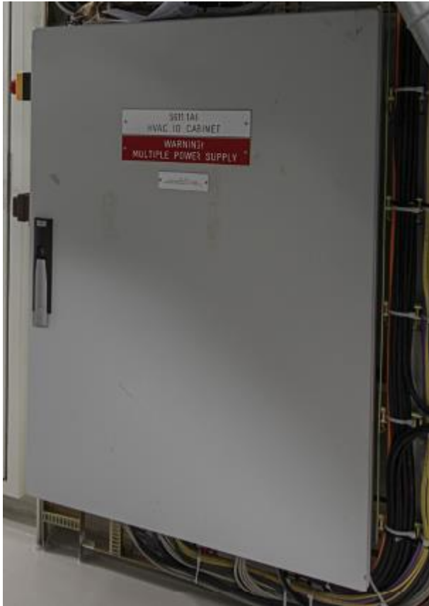
Kuva 11. 063A-moduulin automaatiokaappi (Meyer Turku Oy 2015).
