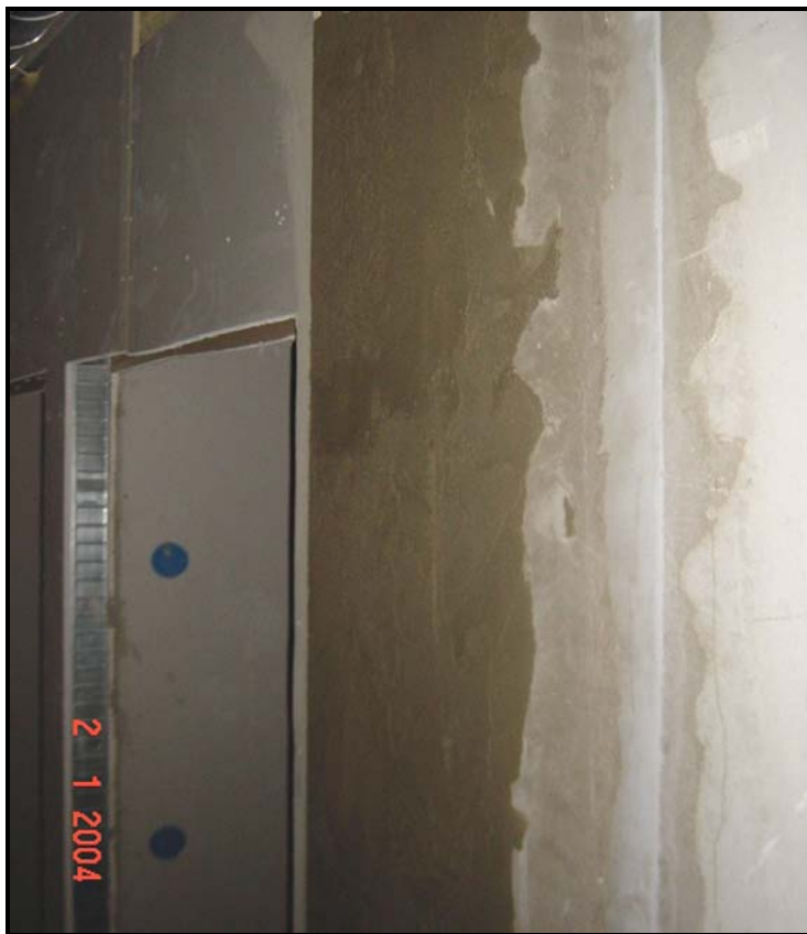
Kuva 18. Tasoitettu hormin pinta näkyy tummemmalla kuvassa.
