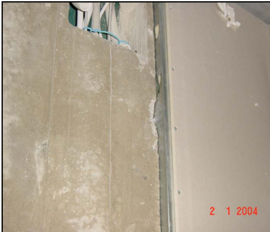
Kuva 8. Hormin päälle on jätetty vara gipsilevyille.
