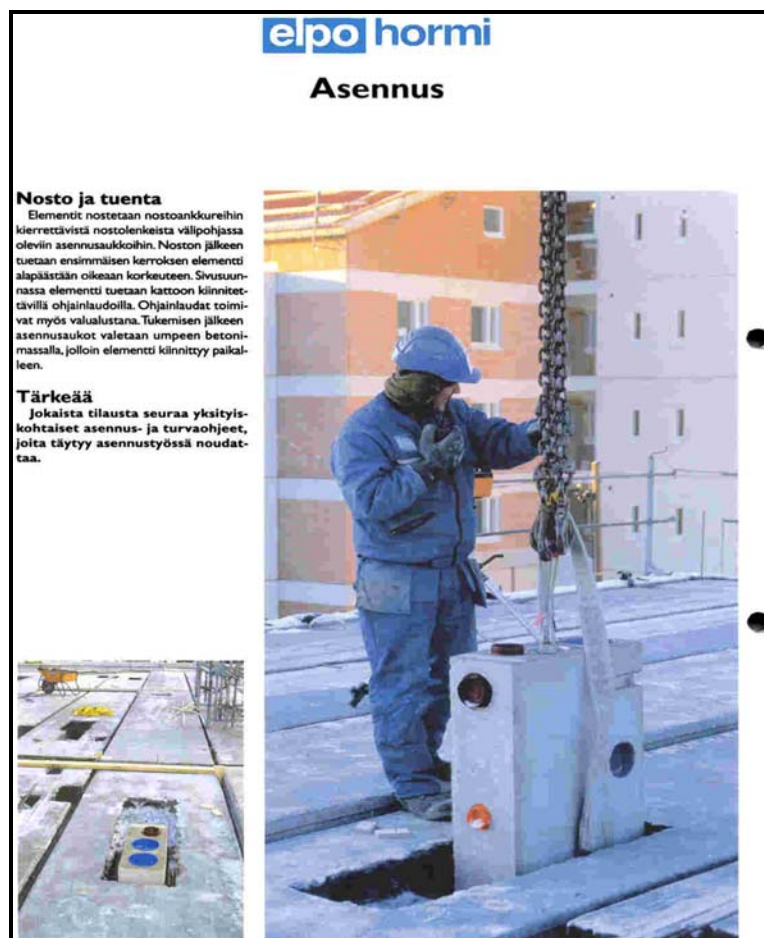
Kuva 4. Elpojen asennus käynnissä.
