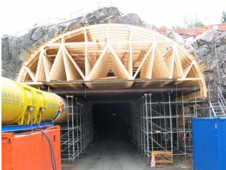
Kuva 6 Suuaukkorakenteen holvin muottirakenteet (läpiajettava tunneli)
