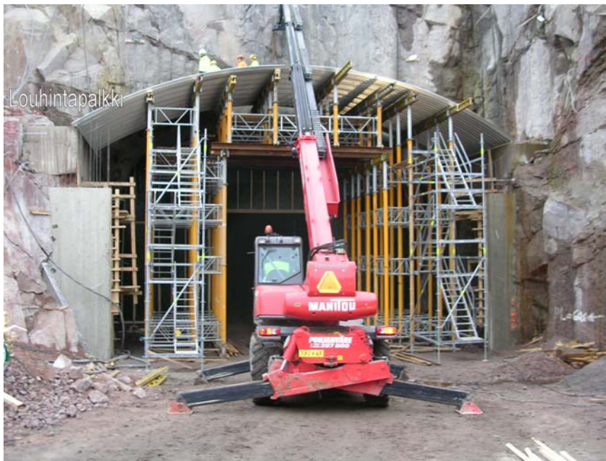
Kuva 23 Lakianmäen pohjoinen suuaukkorakenne rakentamisvaiheessa
