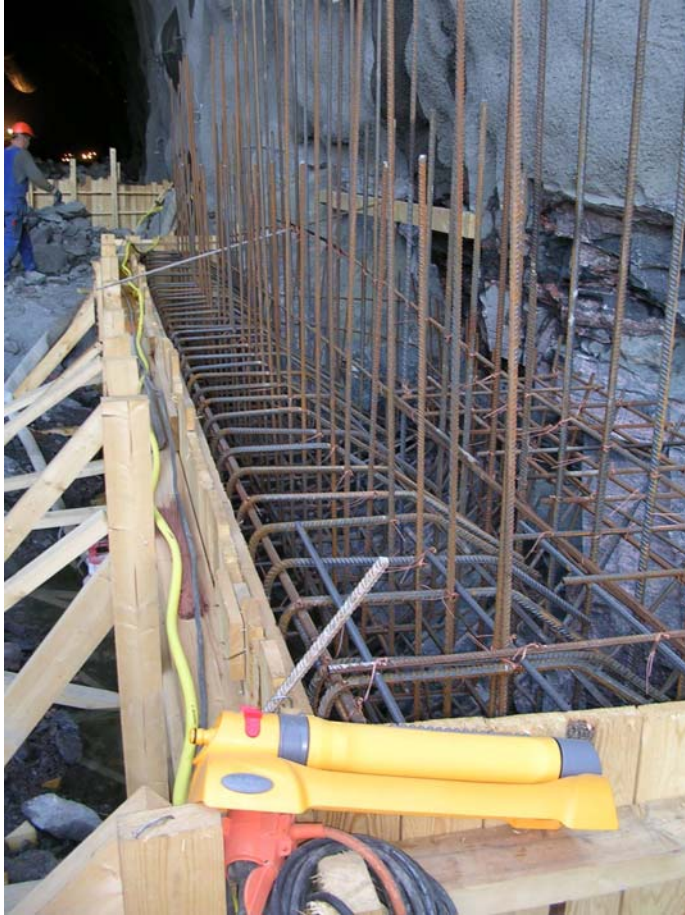
Kuva 4 Suuaukkorakenteen perustus (antura) valmiina valuun
