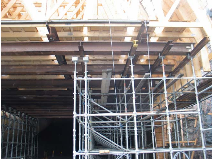
Kuva 19 Holvin telinemuotti (Cuplok-telinejärjestelmä, I-palkit ja kattotuolit)
