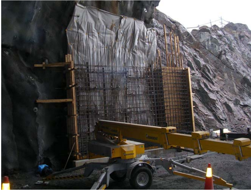
Kuva 5 Suuaukkorakenteen seinä raudoittamisen jälkeen
