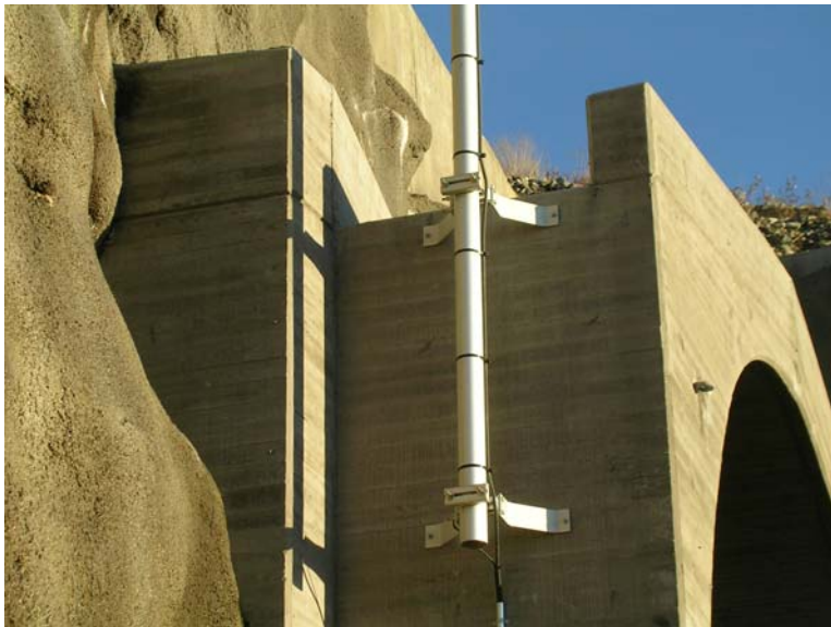
Kuva 3 Suuaukkorakenteen otsapalkki valmiina rakenteena
