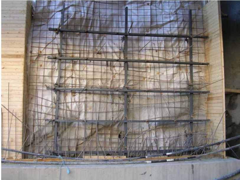
Kuva 18 I-palkkiristikko muottisiteiden kiinnitykseen
