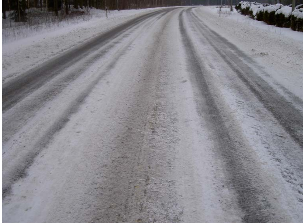
Kuva 12 Kuvassa vasemmalla on kuorma-autolla aurattu ajokaista ja oikealla liikennetraktorilla aurattu ajokaista.
