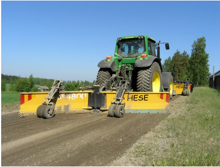
Kuva 11 Soratien tasaus HESE-monitoimipuskulevyllä /11/
