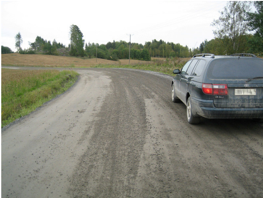
Kuva 15 Rämsöö-Härkälä 9.9.2008. Sama kuvauspaikka kuin kuvassa 13. Tie on tasainen, mutta murskeen lisäyksen takia pinnalla on hieman irtoainesta. /15/
