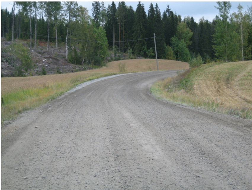
Kuva 18 Rämsöö-Härkälä 18.9.2008. Vastaava kohta kuin kuvissa 14 ja 16. Tien pinta syyskunnostettu tiehöylällä. Tien kuntoarvo tasolla 4. /15/
