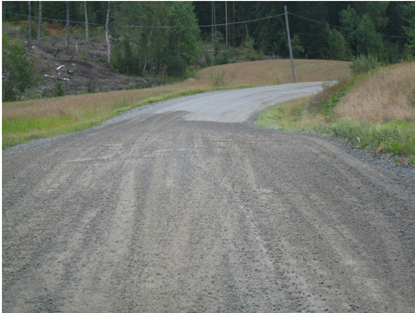
Kuva 16 Rämsöö-Härkälä 9.9.2008. Sama kuvauspaikka kuin kuvassa 14. Tien reiät on tasattu ja levitetty mursketta. Pinta ei ole ehtinyt täysin kiinteytyä. /15/
