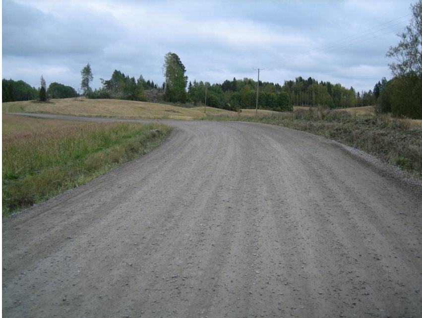
Kuva 17 Rämsöö-Härkälä 18.9.2008. Vastaava kohta kuin kuvissa 13 ja 15. Tien pinta syyskunnostettu tiehöylällä. Tien kuntoarvo tasolla 4. /15/
