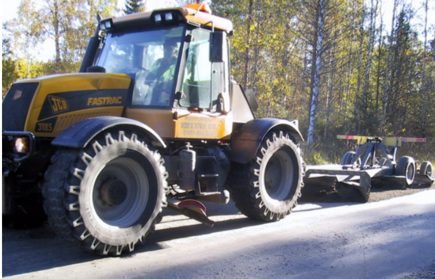
Kuva 8 Soratien tasausta traktorin perään kiinnitettävällä lanalla. /13/
