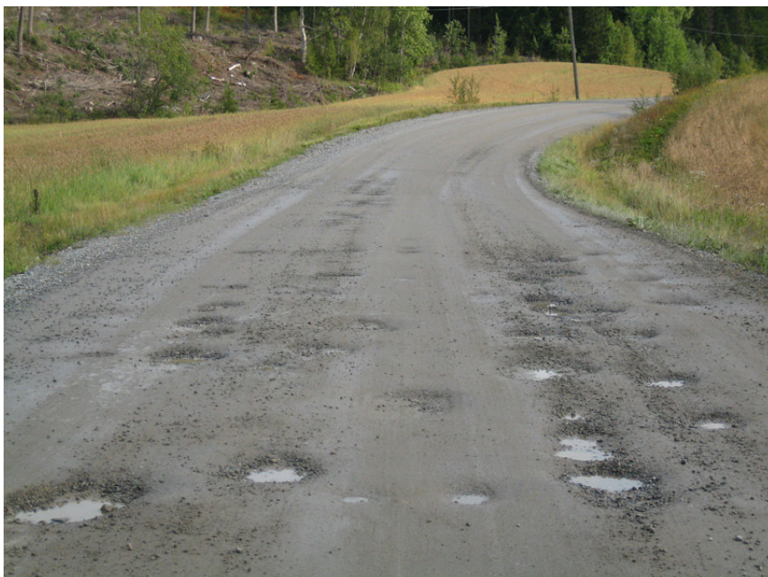
Kuva 14 Rämsöö-Härkälä 5.9.2008. Näkymä kuvauspaikalta Härkälän suuntaan. Tien tasaisuus on reikäsarjojen takia huono, kuntoluokka 2. /15/
