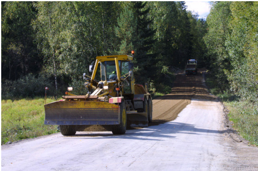
Kuva 6 Tien muokkaushöyläys tiehöylällä /15/
