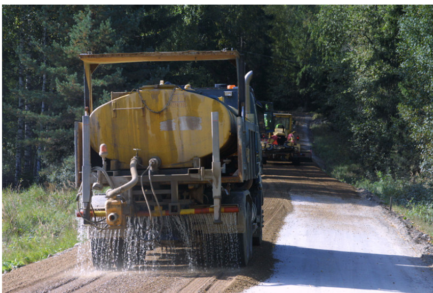
Kuva 9 Tien pölynsidontaa kuorma-auton perään asennettavalla liuoslevittimellä /15/
