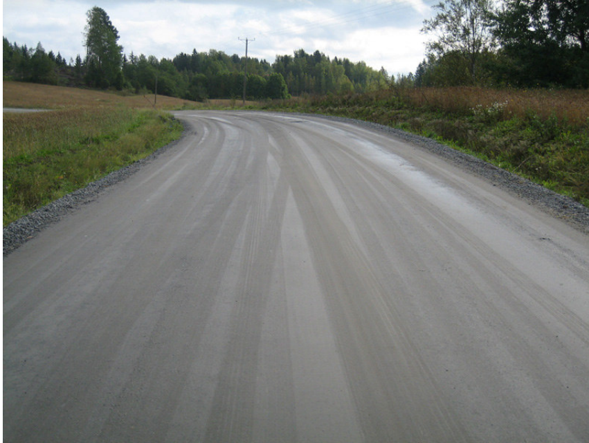
Kuva 13 Rämsöö-Härkälä 5.9.2008 /16/ Näkymä kuvauspaikalta Rämsöön suuntaan. Tien tasaisuus ja kulutuskerroksen kiinteys ovat erinomaiset, eli luokassa 5. /15/
