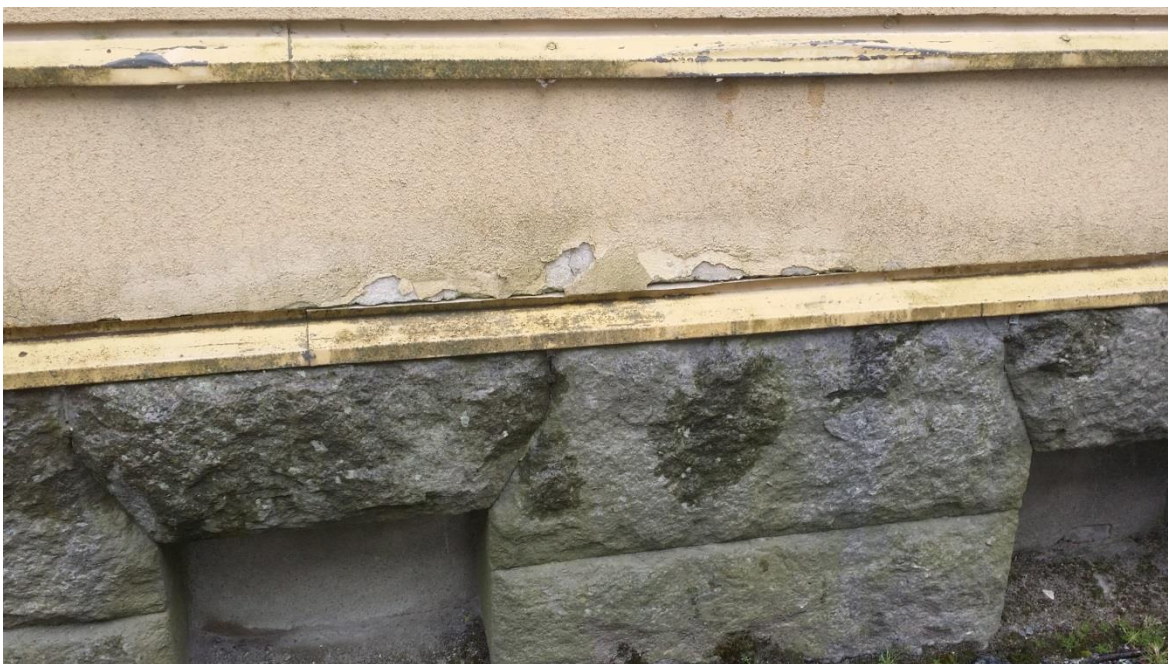
Figur 11. Rappning som har lossnat
