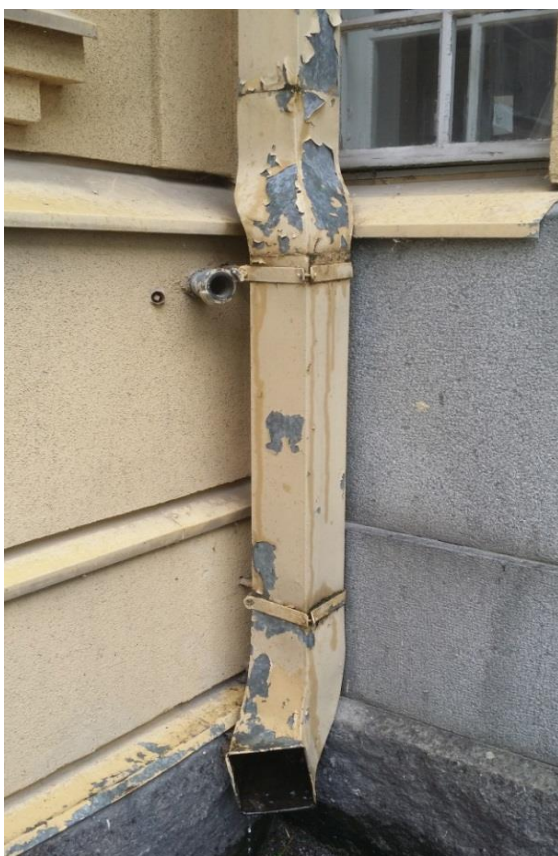
Figur 14. Stupränna som behöver restaurering och tillfällig lappning
