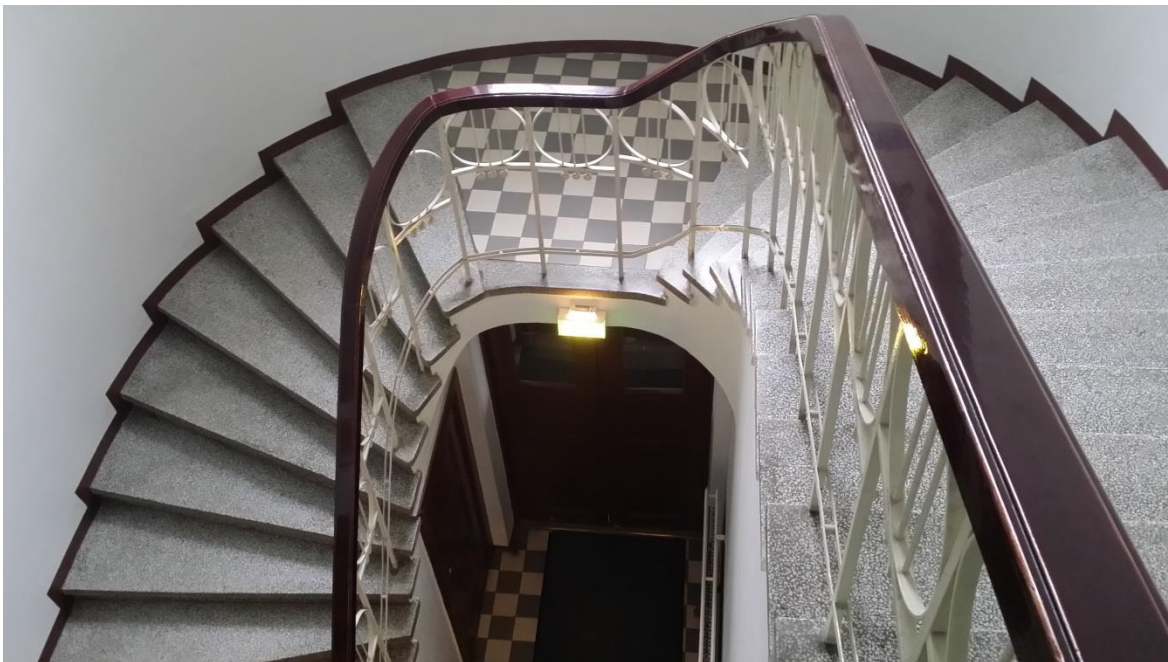
Figur 21. Trapphus i huvudbyggnaden
