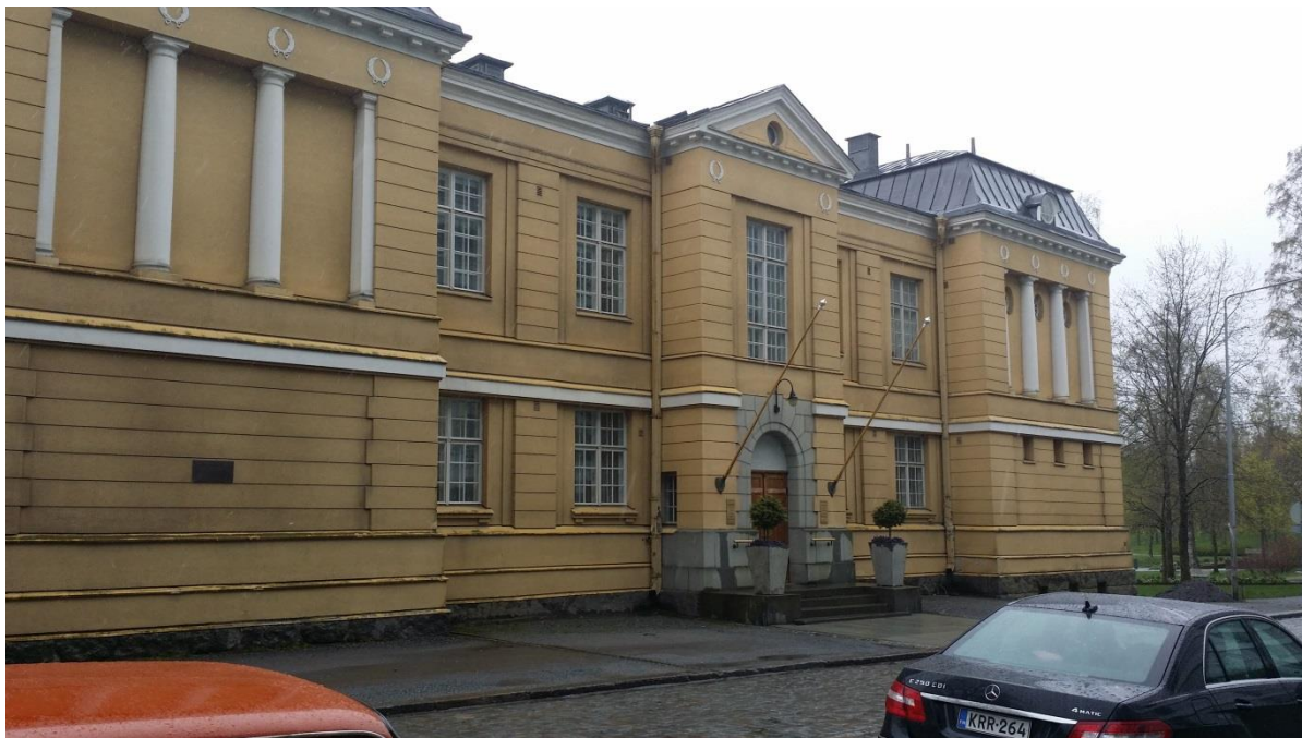
Figur 10. Fasad mot Strandgatan
