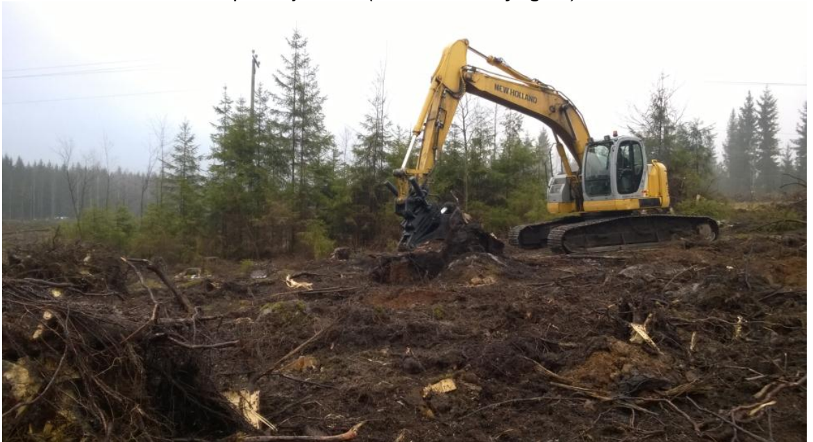
Kuva. 4: Kannonnosto kaivurilla, jossa kannon halkaiseva korjuupää (Kuva: Ismo Kyngäs.)
