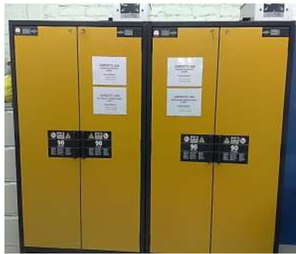
Kuva 7. Paloturvakaapit 90 minuutin paloluokituksella. Lisävarusteena kiertoilma- ja suodatinyksikkö. Toimittaja Knorring Oy Ab
