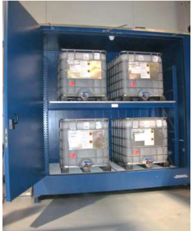
Kuva 4. 120 minuutin paloluokiteltu erikoiskontti. Valtra Oy, Suolahti. Toimittaja Knorring Oy Ab.
