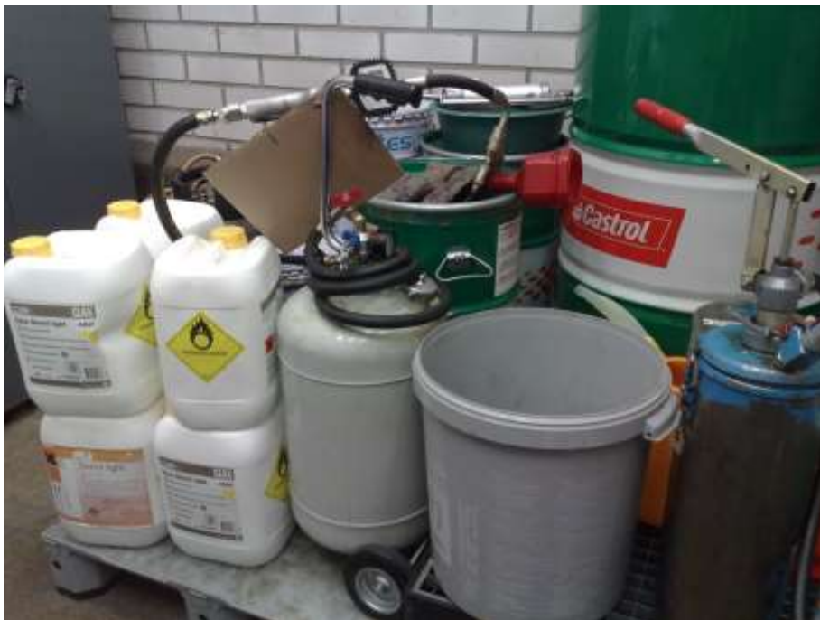
Kuva 2. Hapettavat tuotteet ja palavat nesteet samassa varastossa.
