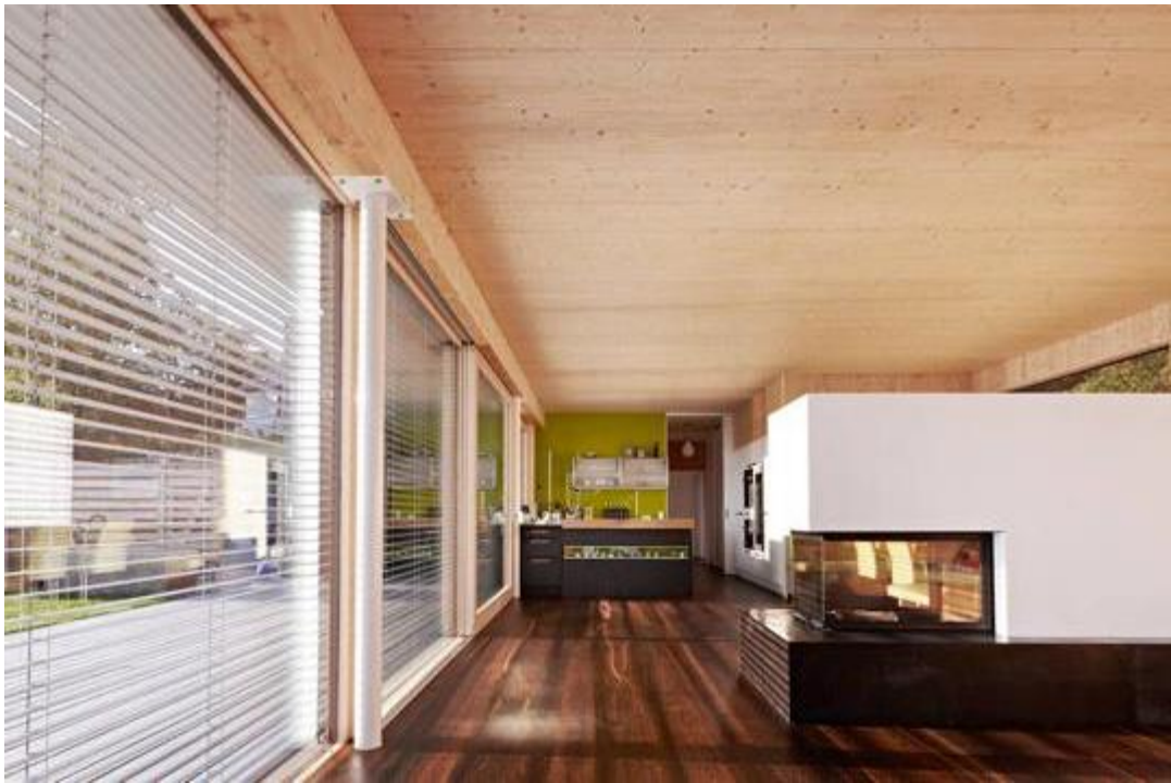
Kuva 3. CLT säilytetty sisäkaton pintamateriaalina (4.)
