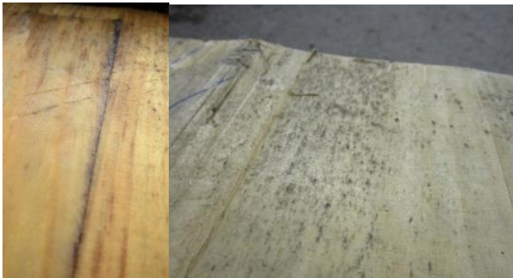
Kuva 31. Koekappale LEVY 3, kosteuden aiheuttamia vaurioita
