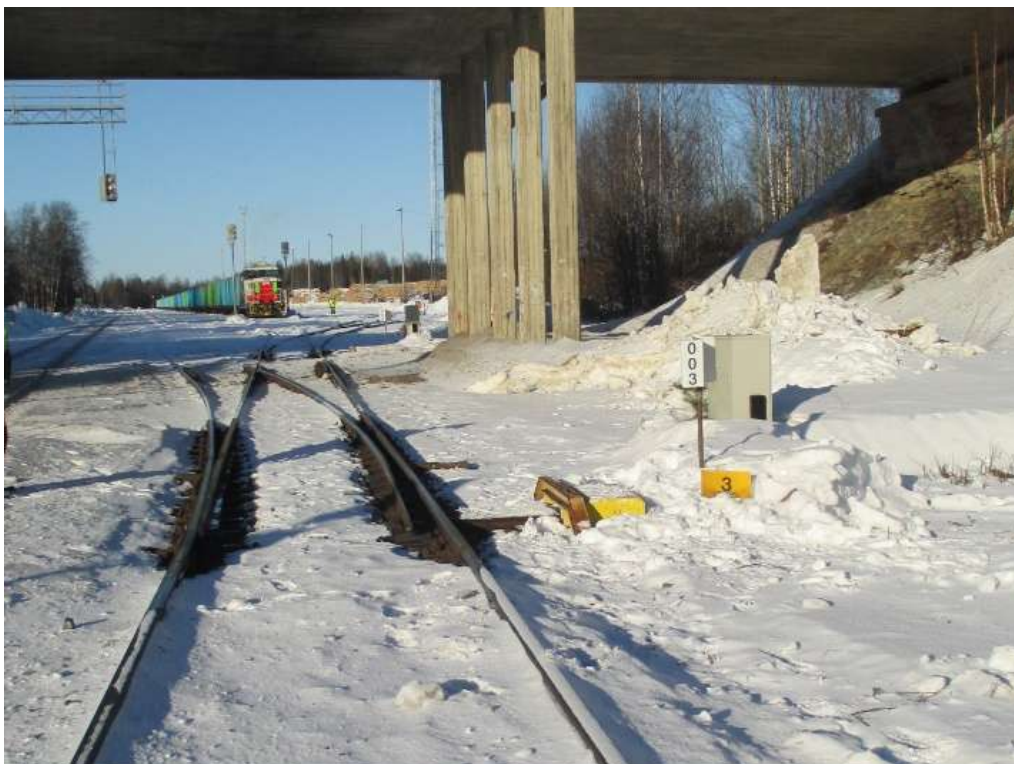
KUVIO 3. Sähkökääntölaitteella varustettu YV54-200-1:9-V vaihde
