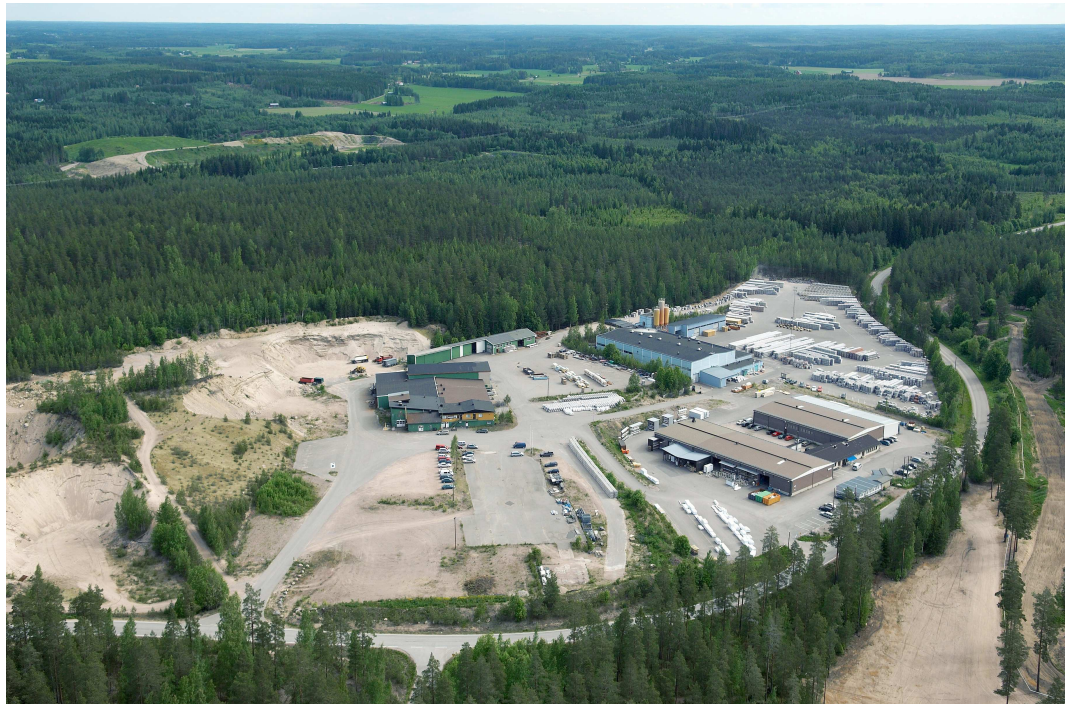
KUVA 1. Ilmakuva yrityksen tehdashalleista (Hermetel 2014)
