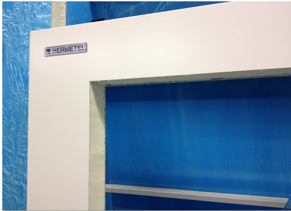
KUVA 2. Oven pintapellit ja eristerakenne
