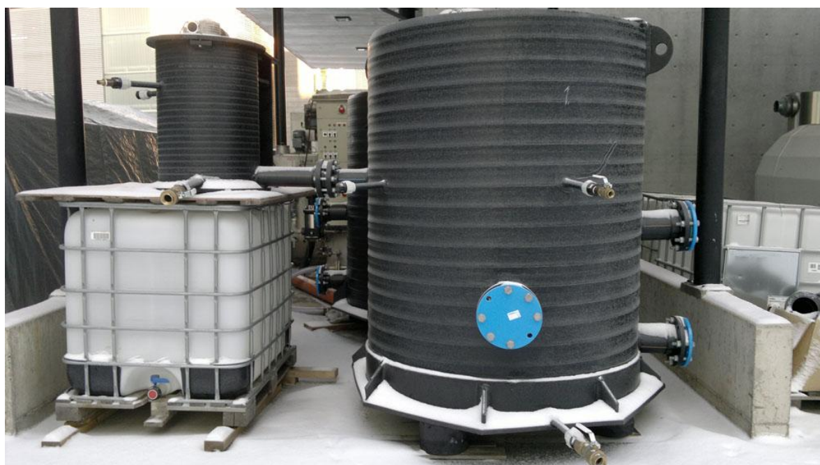
Kuva 12 Vasemmalla 1,0 \text{ m}^3 suuruisen IBC-säiliön päällä on pikasekoitusallas ja oikealla siihen kytkettynä on toinen hämmennysaltaista (Huttunen 2015-01-07).
