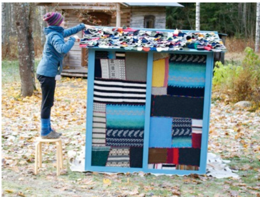
Kuva 33. Kattokankaat levitetään vanerikaton päälle.
