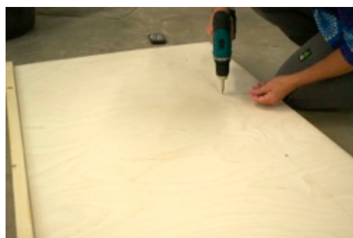
Kuva 22. Katon tukirimojen kiinnitys.
