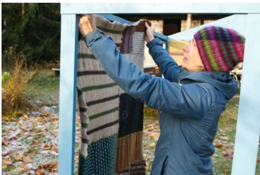
Kuva 32. Villaiset seinäkappaleet painellaan tarranauhoihin kiinni.
