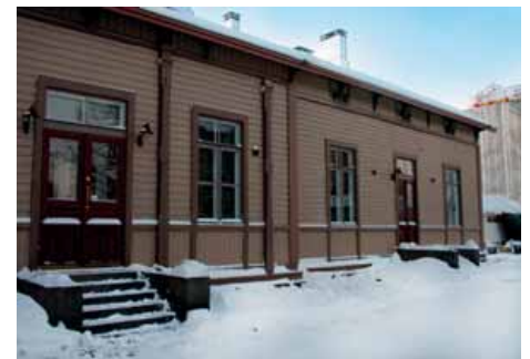
Kunnostettu julkisivu uusittuine laudoituksineen töiden loppuvaiheessa
