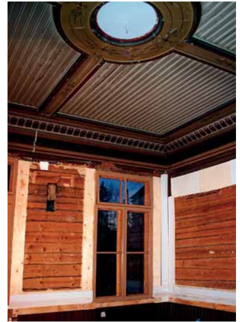
Restaurointityöt hirsirakennuksen sisätiloissa edistyvät
