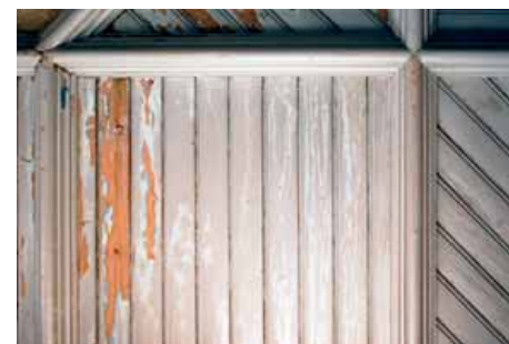
Odotussalin katto maalin kaapimisen jälkeen
