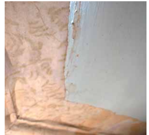
Myöhempien maalausten alta erottui alkuperäinen koristemaalaus
