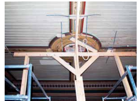
Keisarillisen odotussalin katto koristeineen nostettiin varovasti oikeaan korkeuteen ja tuettiin aloilleen
