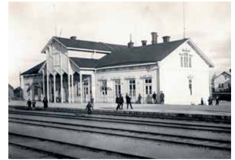
Asema julkisivumaalauksen jälkeen 1920-luvulla
