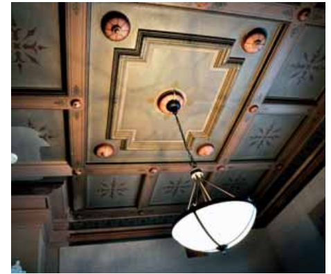
Keisarillisen salongin katto paikkauksineen
