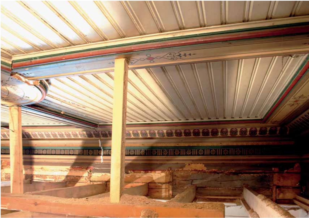
Keisarin odotussalin kattopinnot avattuina ensimmäistä kertaa vuosikymmeniin
