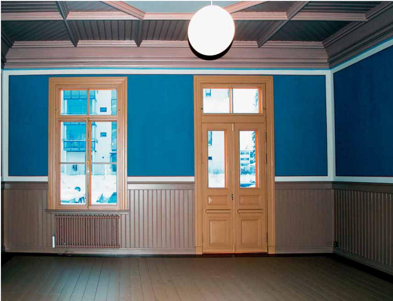
1. ja 2. luokan odotussali restauroinnin jälkeen
