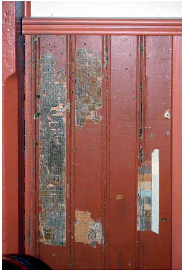
Esiinotettuja pintoja 3. luokan odotussalissa
