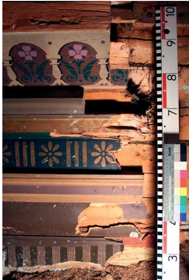
Karniisilistoitus oli sahattu moottorisahalla putkien läpivientiä varten
