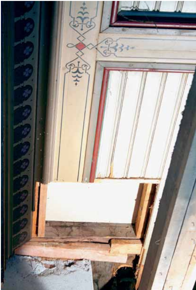
Myös osa odotussalin katosta oli purettu ullakolle vievän luukun tieltä
