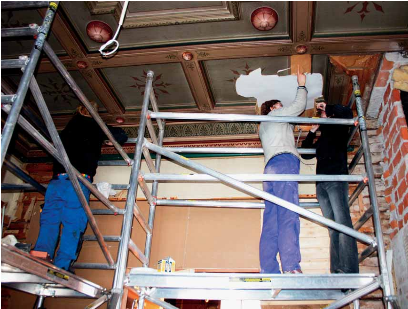
Opiskelijat asettavat paikkapalaa katon ja alkuperäisen pinkopahvin väliin
