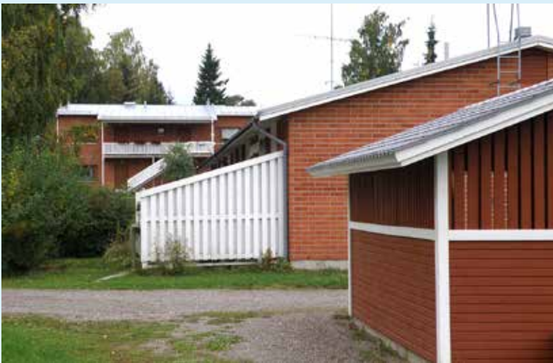
KUVA 9. Huittilanjoen rantaan 1970-luvulla rakennettuja rivitaloja
