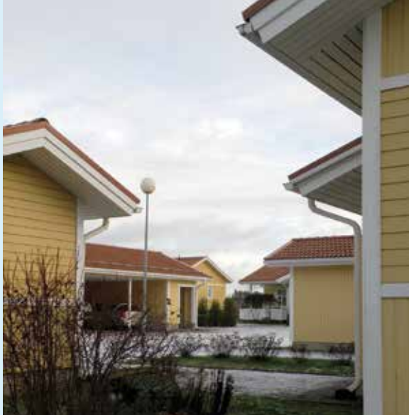
KUVA 7. Sysmän pientalorakentamista 1990- ja 2000-luvuilta
