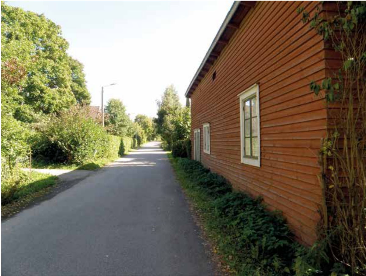
KUVA 119. Katunäkymä Maalarintiellä. Katu rajautuu Koittolan piharakennuksen vaakalaudoitettuun julkisivuun.
