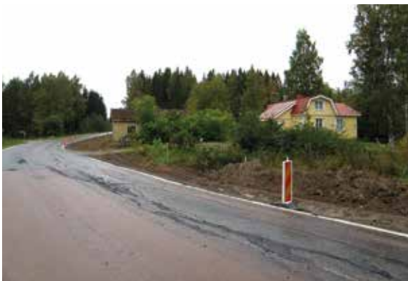
KUVAT 141 ja 142. Suopellontien rakennustöitä vuoden 2013 syksyllä.
