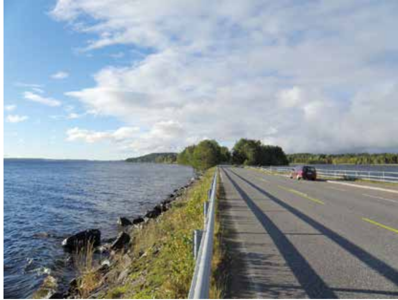
KUVA 1. Pulkkilanharjun kautta kulkeva tieyhteys
