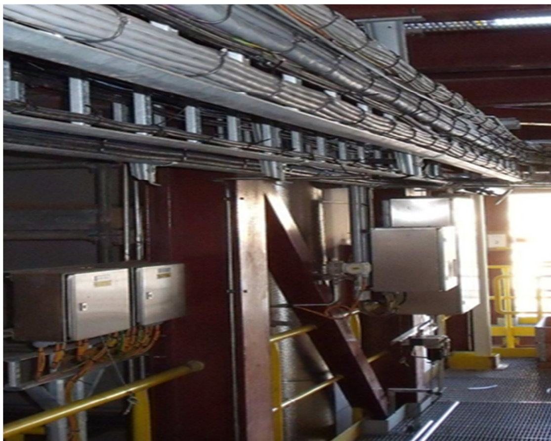
KUVA 6. Matalan tilan kaapelihyllyasennus, kiinnitys tehdään pysty- ja yläpalkkiin.
