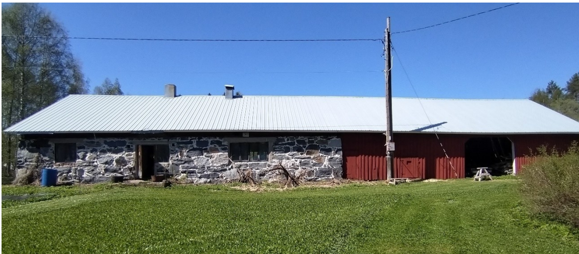
KUVA 8. Laitakankaan kivinavetta idän suuntaan kesällä 2024
