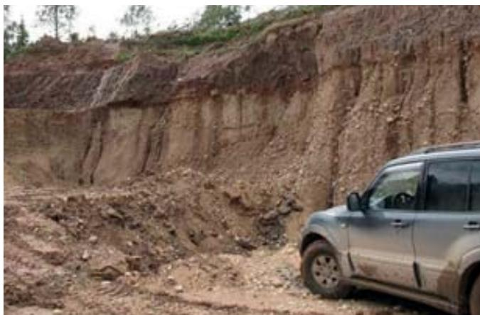
ФОТО 4. Каменистый материал для строительства верхнего слоя дороги под 2-метровым слоем глины в Тихвине (Greis).
