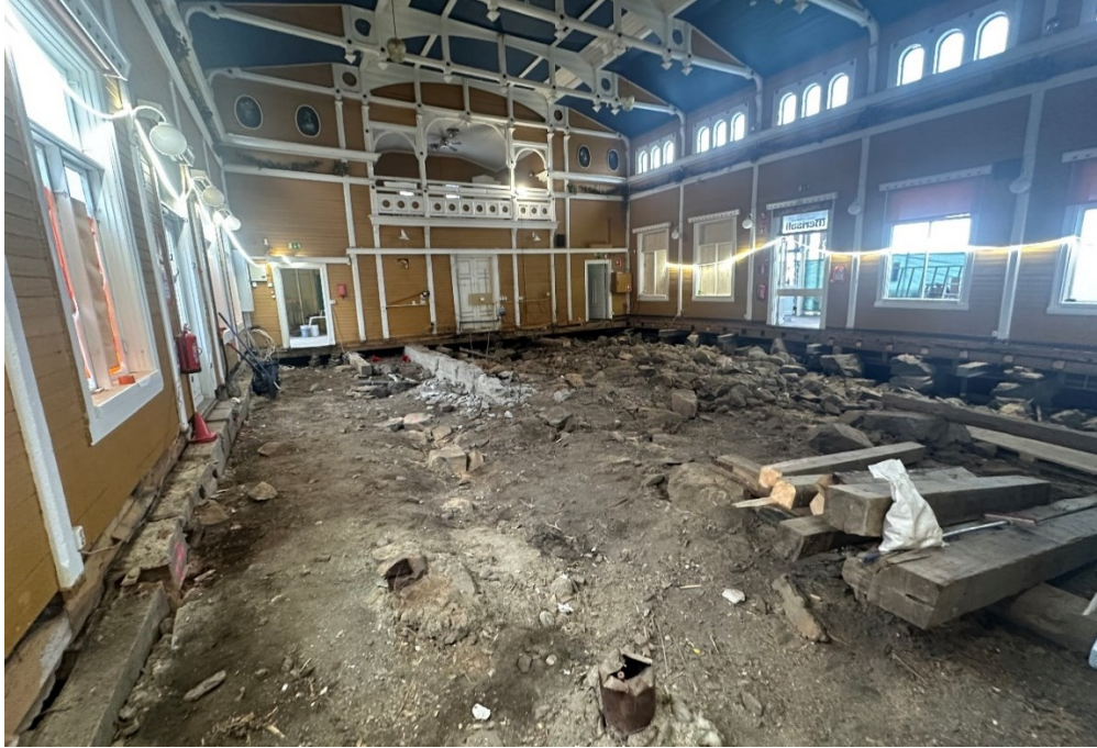
Kuva 3. Merisalin lattia avattu.
