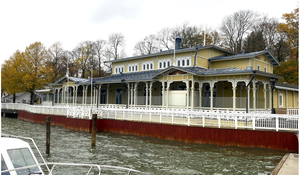
Kuva 2. Naantalin Merisali remontoituna lokakuussa 2024.
