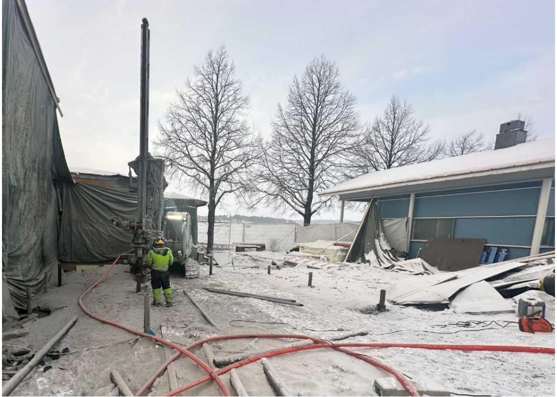
Kuva 6. Uudisosan paalutustyöt käynnissä talviolosuhteissa.
