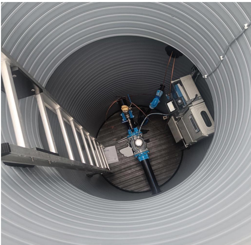
Kuva 5. Lining mittakaivon sisusta 2, (Oma kuva 2023)
