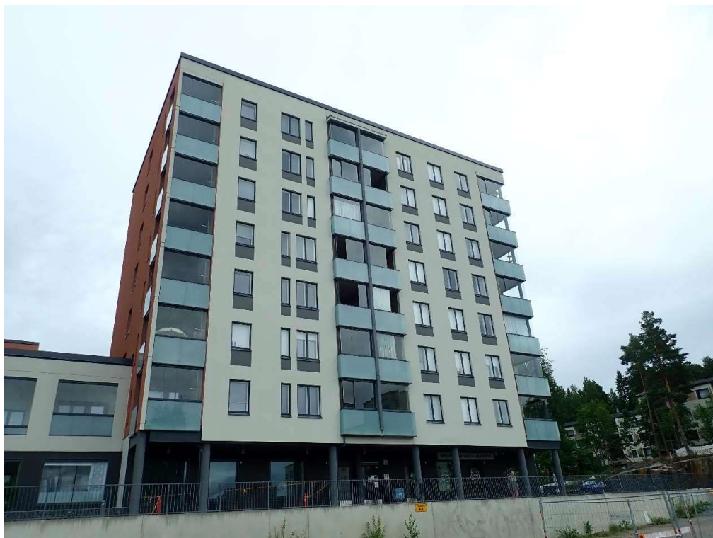
Kuva 3. Yleiskuva A-talon eteläpuolen julkisivusta.
