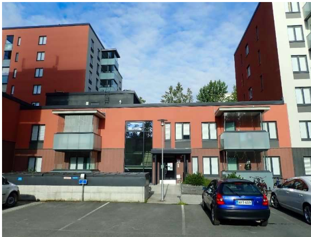
Kuva 30. Yleiskuva C-talon idän puoleiselta julkisivulta.
