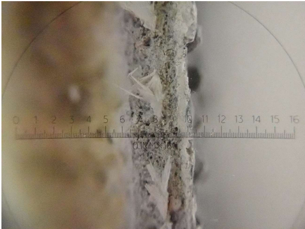
Kuva 17. Kuvassa rappauksesta otettu lieriönäyte, josta nähtävissä rappausverkon sijaitsevan lähes laastikerroksen keskellä. Laastikerroksen kokonaispaksuuden ollessa noin 3,5 mm (Vahanen Rakennusfysiikka Oy 2022)
