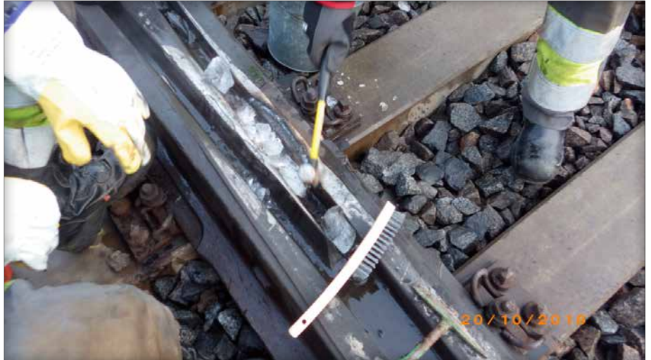
Mangaaniteräsristeyksen kunnostushitsausta ja lämpötilan hallintaa jääpalojen avulla.
