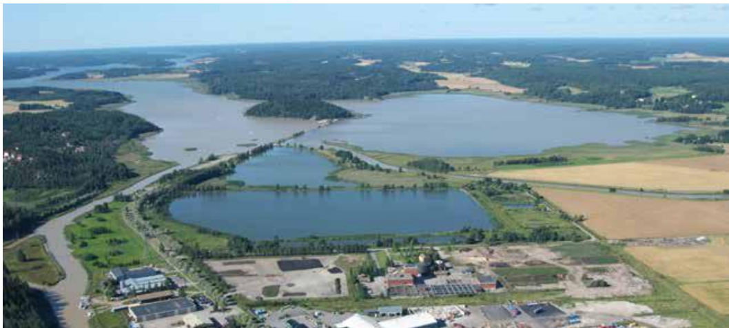
Kuva 6. Salon entiset jätevesialtaat. Kuva: Liikelaitos Salon vesi.
