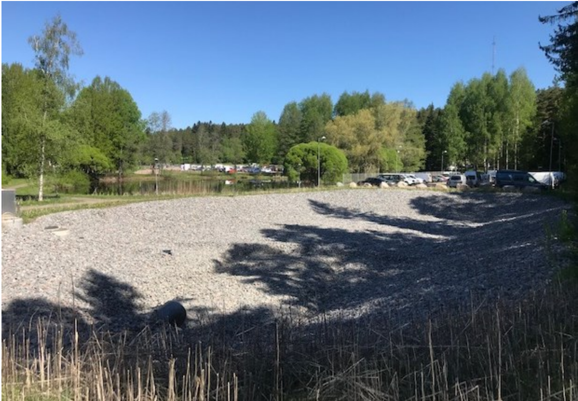
Kuva 11. Assi-sairaalan imeytysaltaaseen johdetaan hulevesiä sairaalan alueelta.
