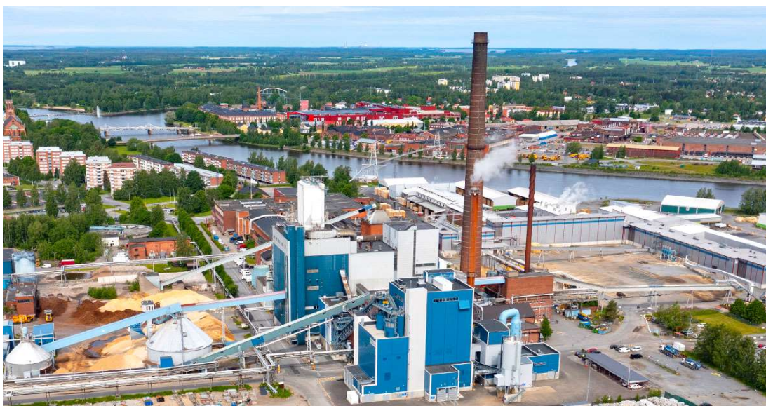
Kuva 1. Aittaluodon voimalaitos (Pori Energia).
