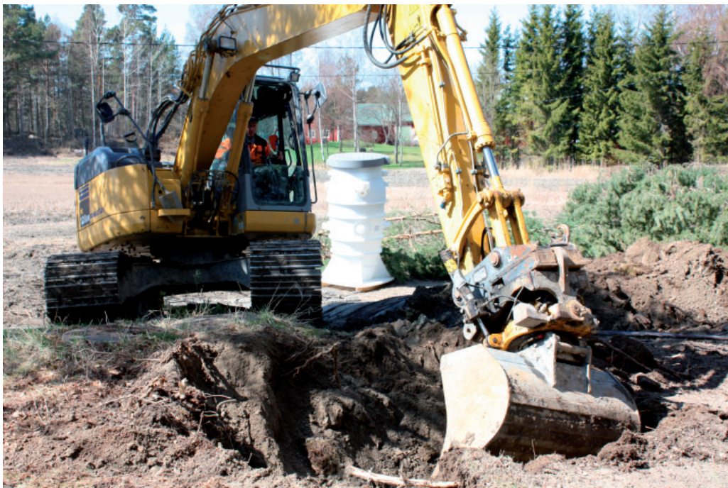
KUVA 9. Pumppaamon asennus työnäytöksenä.
