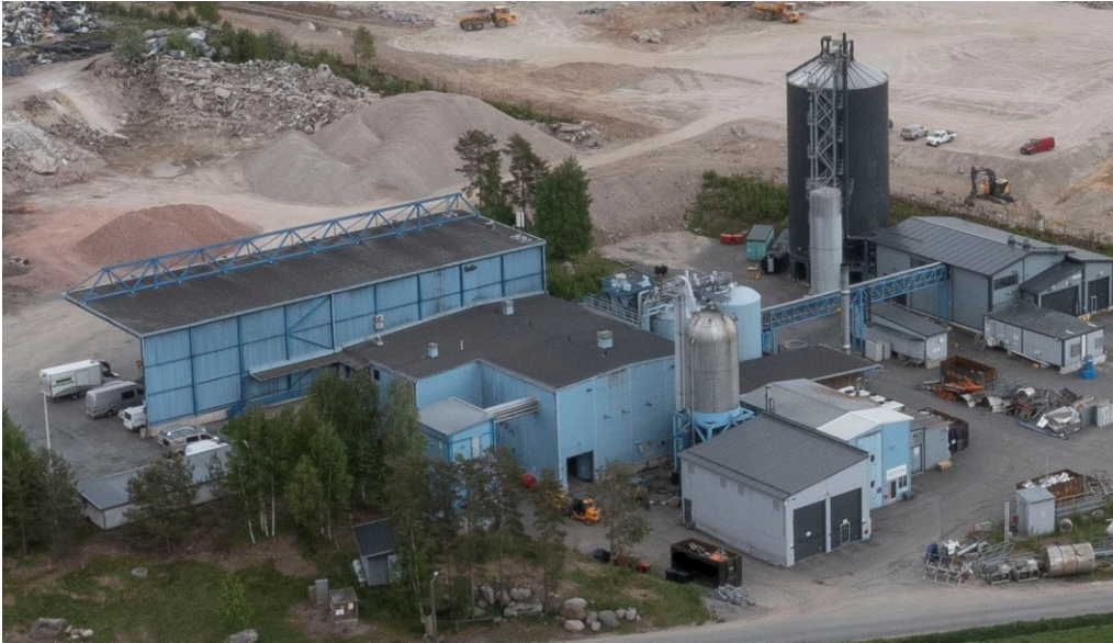
Kuva 1. PUHI Oy:n laitosaluetta Karanojan alueella Hämeenlinnassa (PUHI Oy, 2023).
