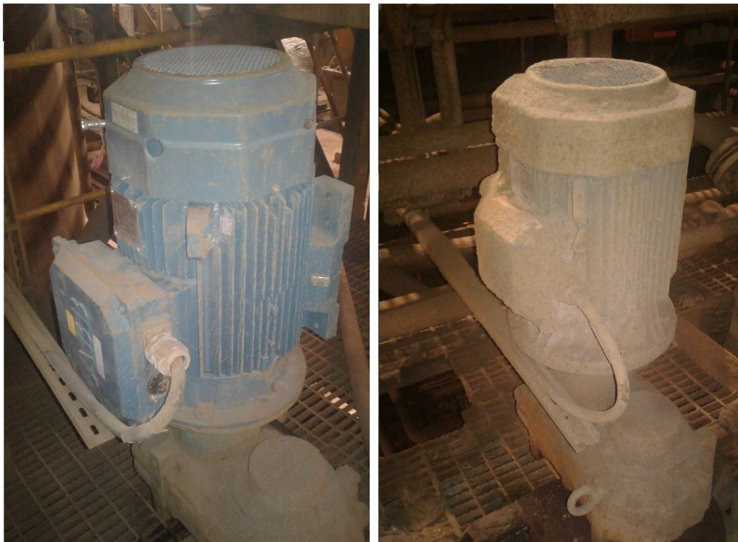
Kuvio 28. Moottorilla väärä asennusasento ja likainen moottori
