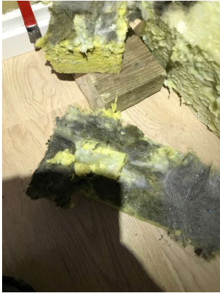
KUVA 21. Ulkoseinän eristeet rakenneavauksessa (Entavision Oy 2024)
