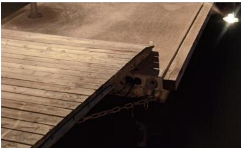
Figur 3. Förankringar med kättingar. En betongponton vid en småbåtshamn. (Winkelmann, 2024).
