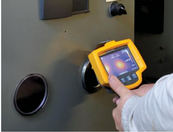
Kuva 15 Infrapunaikkuna (Schneider. 2019)
