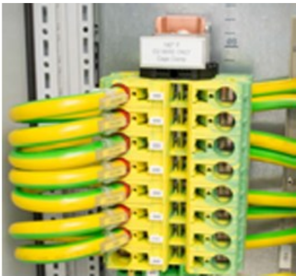
Figur 38: Jordningsterminaler (med temperaturmärkning, typ av ledare och cage clamp). (Industrial Control Panels and Electrical Equipment of Industrial Machinery for North America, 2014).
