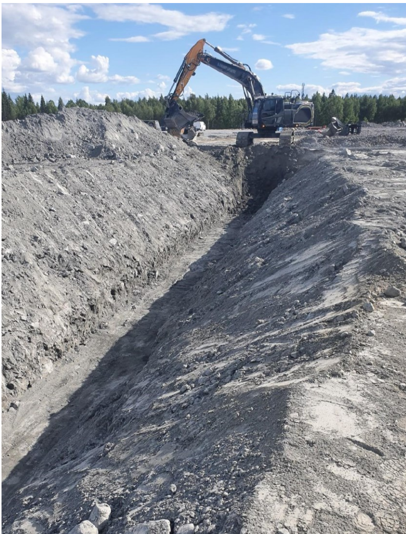
Figur 7 Schaktning av ledningsgrav
