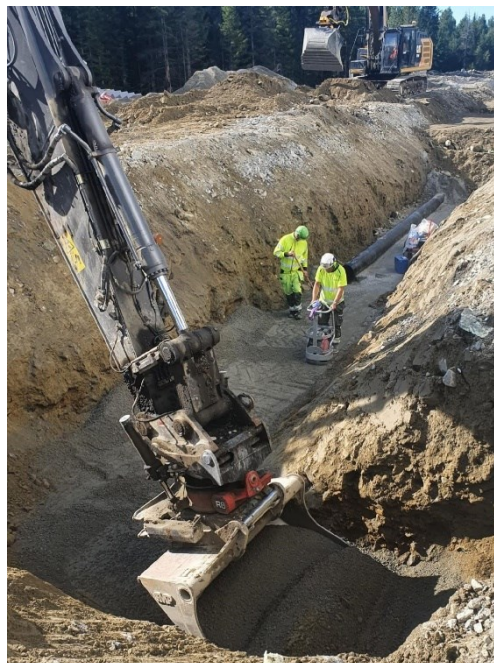
Figur 21 Fyllning och packning av ledningsbädd.
