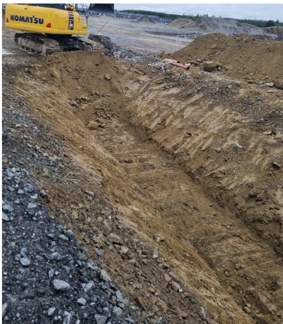
Figur 22 Ledningschakt i morän.
