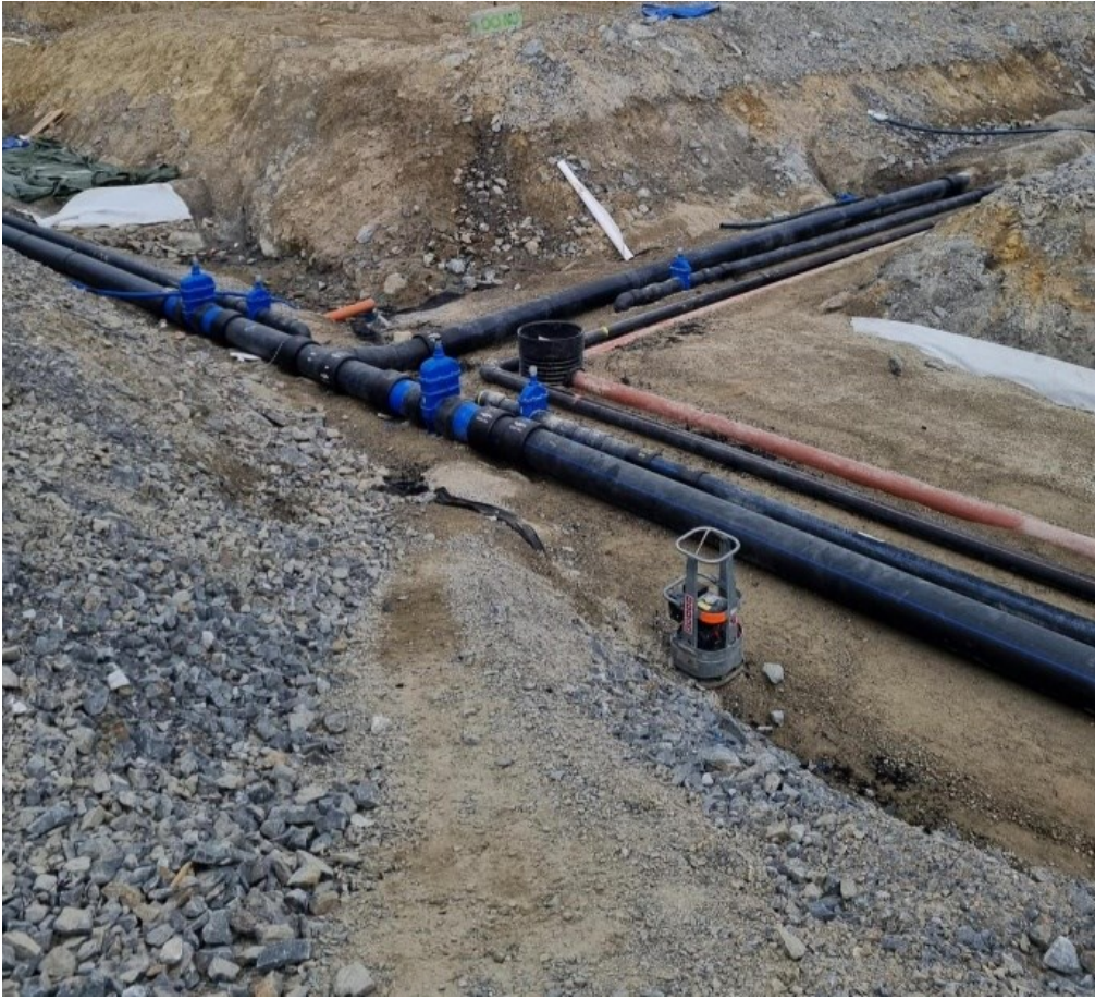
Figur 8 Ledningsgrav med flera ledningar.
