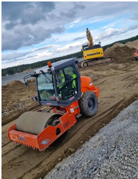
Figur 9 Packning av återfyllt morän med vält
