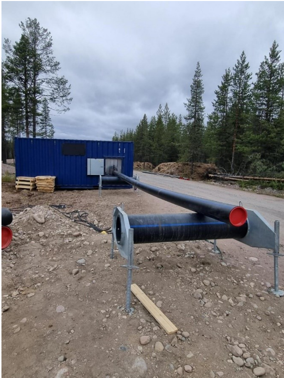
Figur 18 Stumsvetsning av PE rör som utförs i container på arbetsplatsen.
