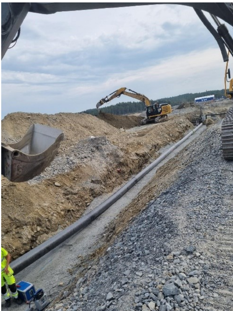
Figur 17 Rörläggning för trycksatt vattenledning samt schakt.
