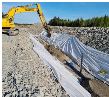
Figur 20 Kringfyllnad av en trycksatt rörledning.
