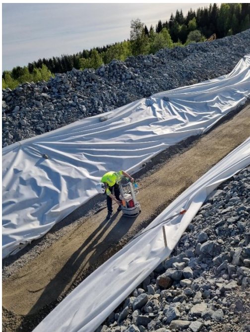
Figur 12 Packning av ledningsbädd
