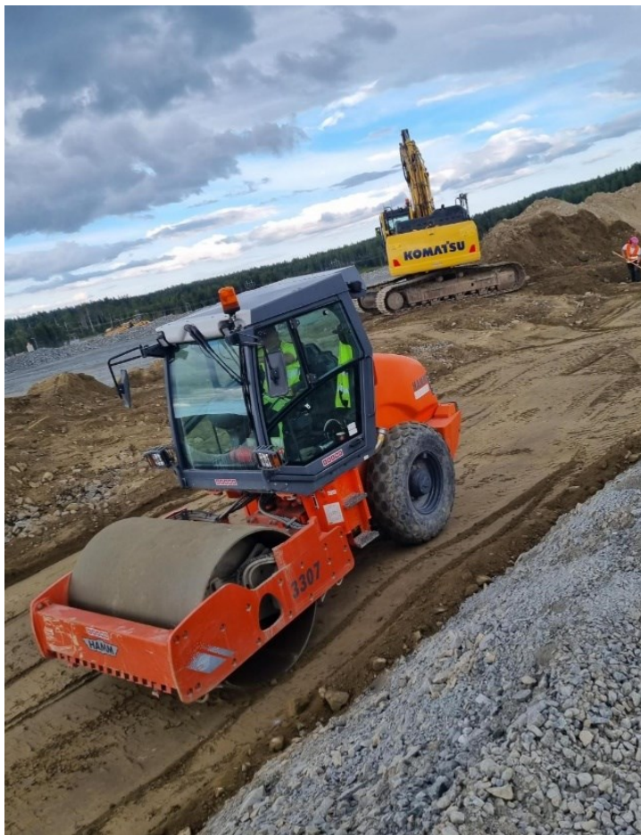
Figur 5 Packning med vält av återfylld morän
