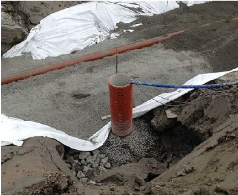
Figur 6 Pumpgrop för länshållning i rörgrav
