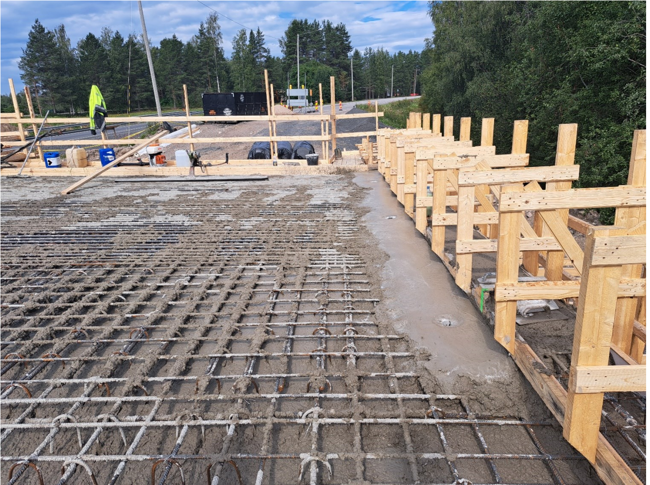
Kuva 1. Teräsbetonisen ulokelaattasillan (Bul) reunapalkin vastavalu (Lakso, 2023).
