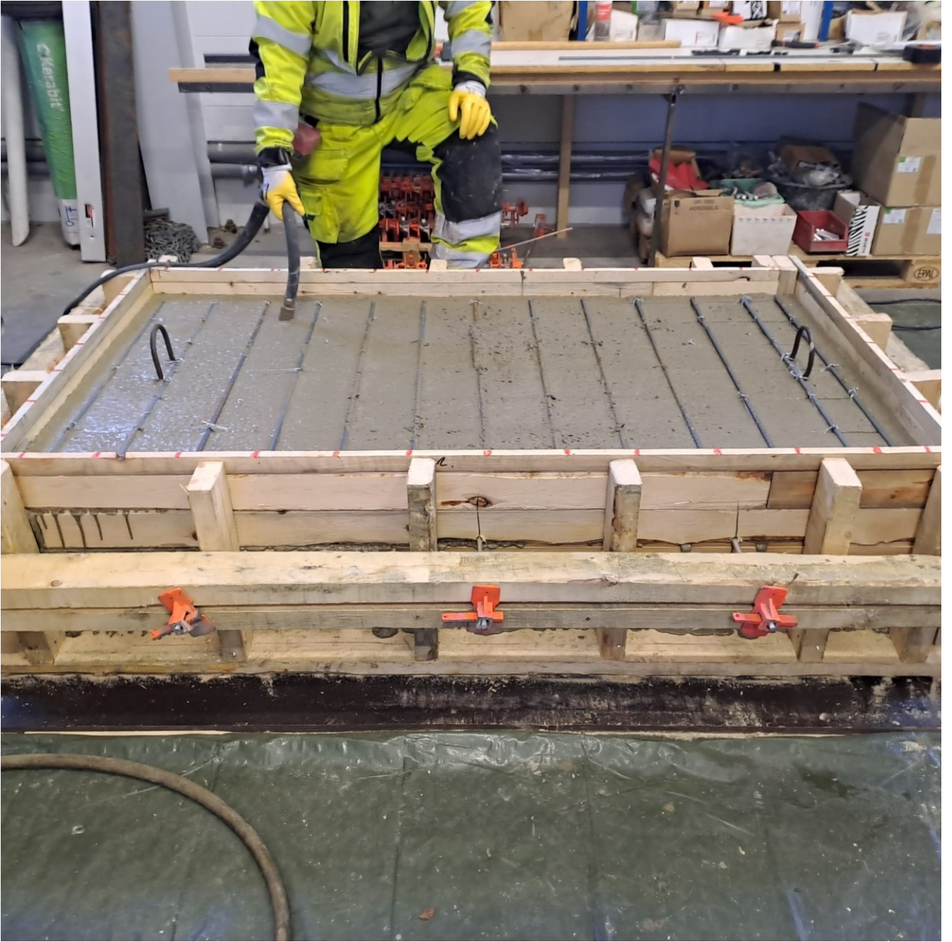
Kuva 5. Sauvatäryttimellä tiivistäminen (Lakso, 2024).
