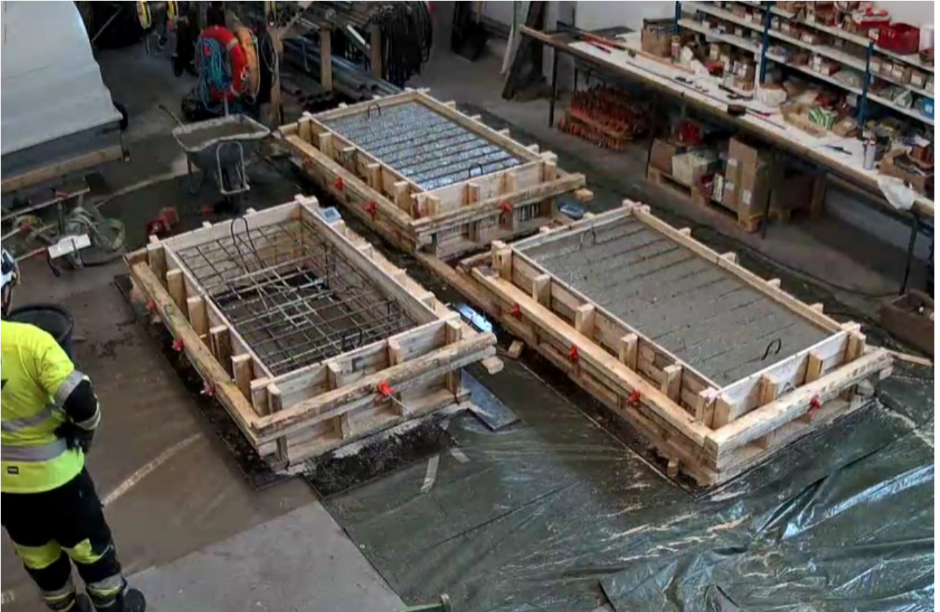
Kuva 4. Valutilanne 1. betonikuorman jälkeen (Lakso, 2024)
