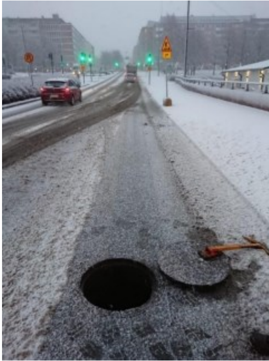
Kuva 6. Tarkkailupiste 9, Vaskiluodon-silta. (Virtanen, 2018.)
