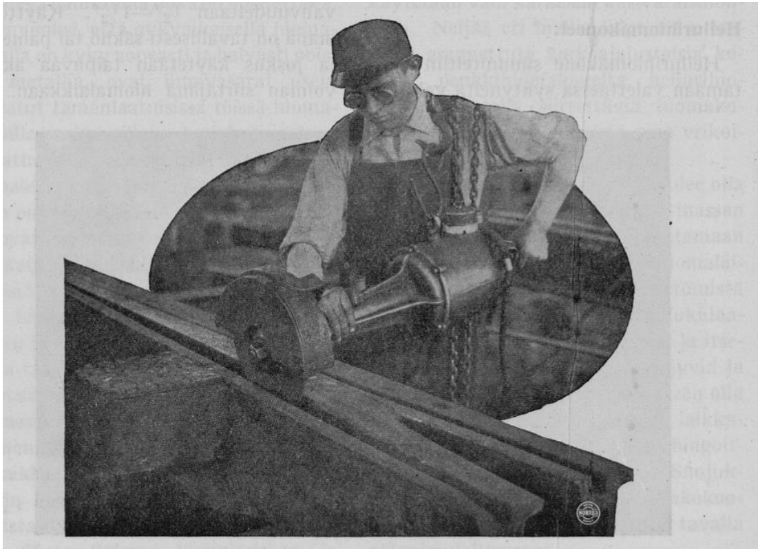
Kuva 3. Siirrettävä sähköhiomakone (Oy Machinery AB, 1932b, s. 4).
