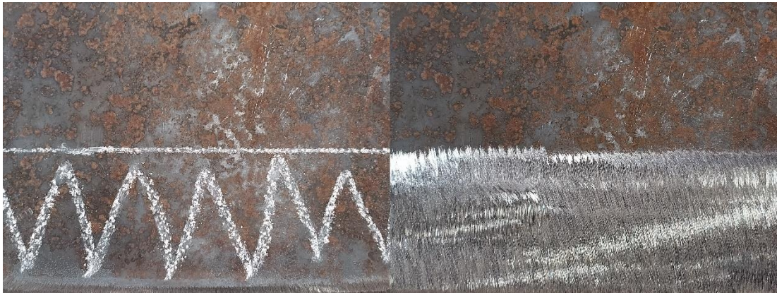
Kuva 27. Hitsauskohdat on merkitty liidulla, jonka jälkeen epäpuhtaudet on poistettu hiomalaikan avulla.
