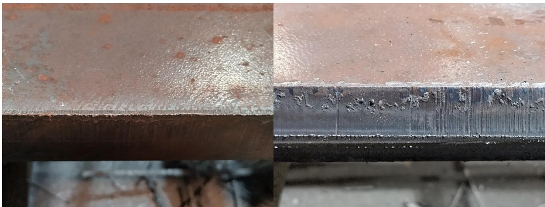
Kuva 28. Levyn reuna ennen ja jälkeen polttoleikkauksella tehdyn hitsausrailon valmistuksen.
