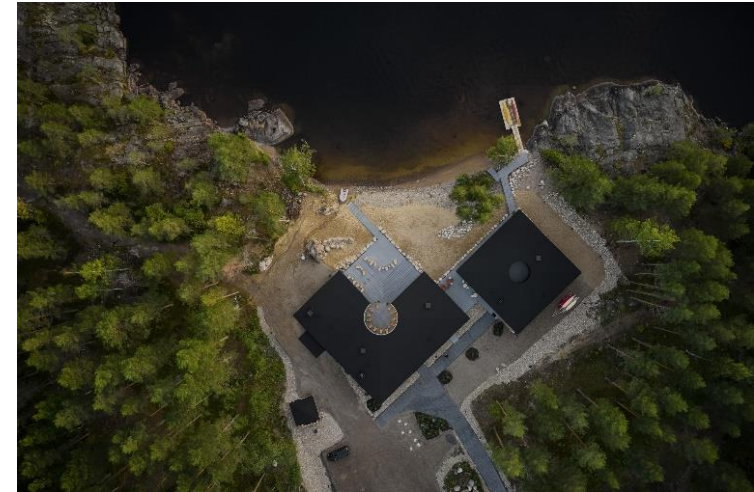
Kuva 25 Pistohiekkä saunaravintola, näkymä ylhäältä
