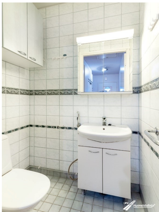
Kuva 3. Wc ennen remonttia.
