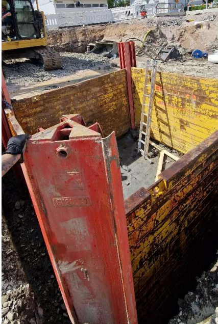
Kuva 1 Elementtien asennus
