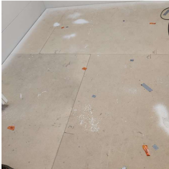
Kuvat 6. Valmislattia rakenne peitettynä MDF-levyillä
