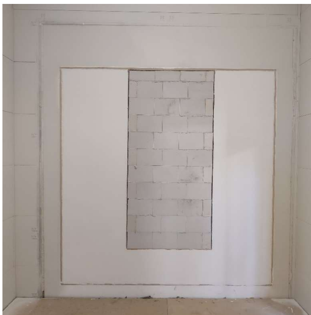
Kuva 8. Valmis väliseinärakenne.
