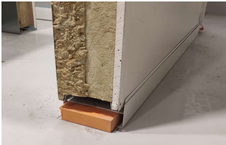
Kuva 4. Akustiikkalaboratorion tärinäeristys, U-kisko ja seinärakenne.
