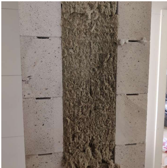
Kuva 7. Väliseinä rakenteen läpileikkaus
