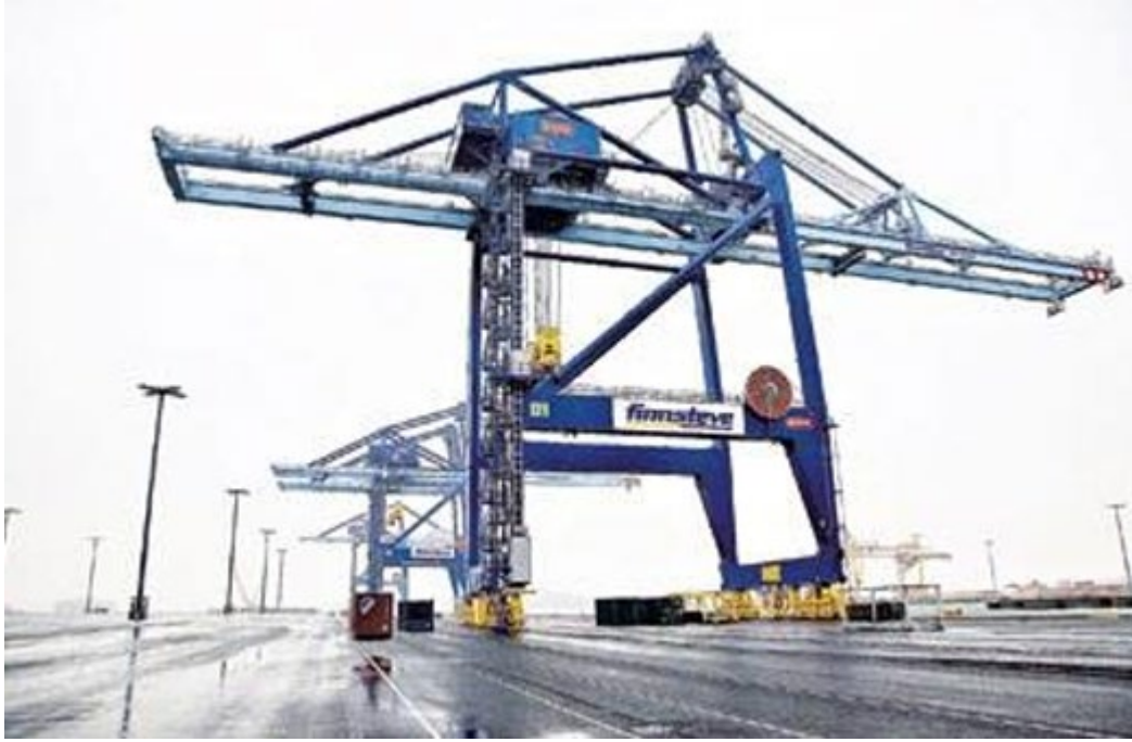
Kuva 10. STS post-panamax crane. (Lähde: Finnsteve 2024)
