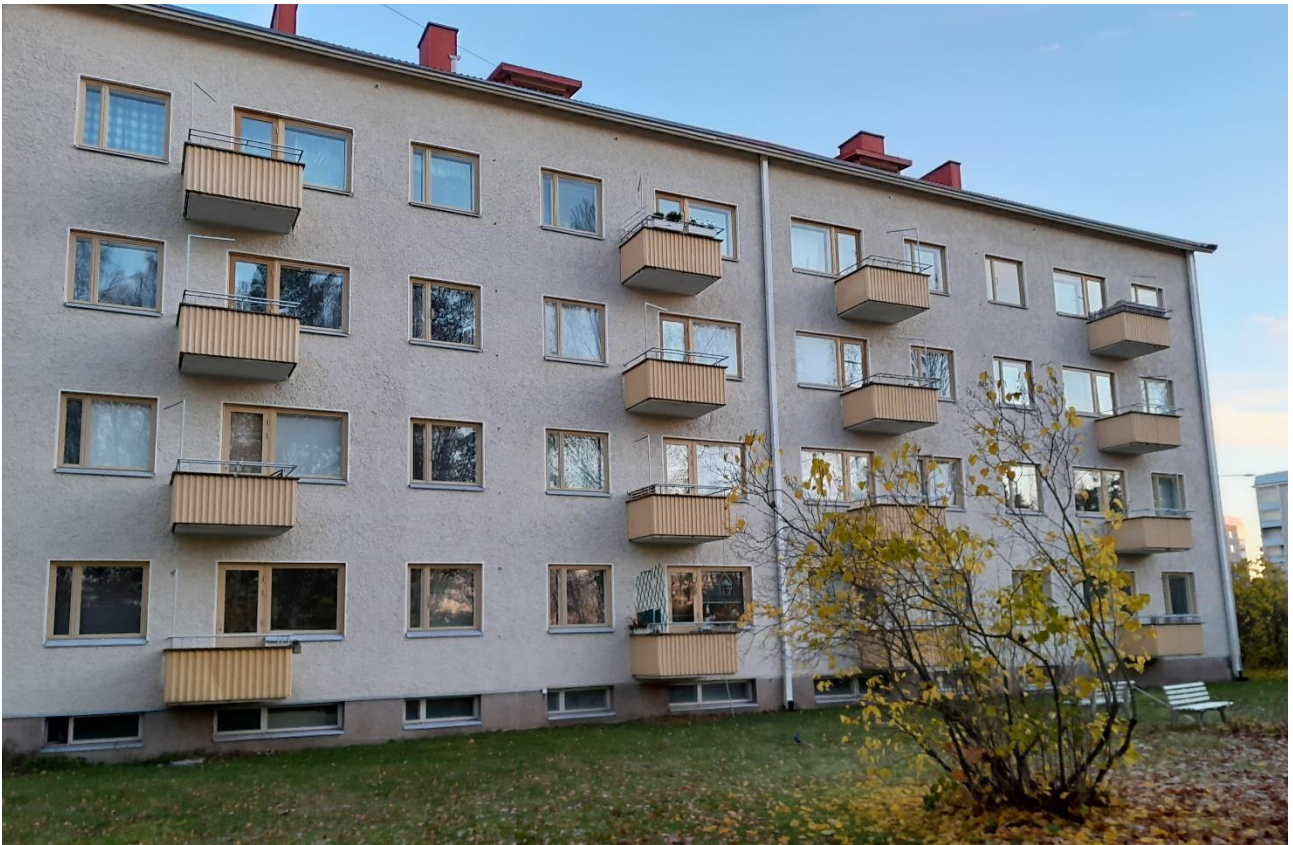
Kuva 1, yleiskuva kohteesta ennen töiden aloitusta.
