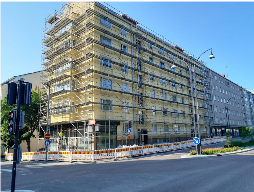
Kuva 2, yleiskuva kohteesta töiden aikana.
