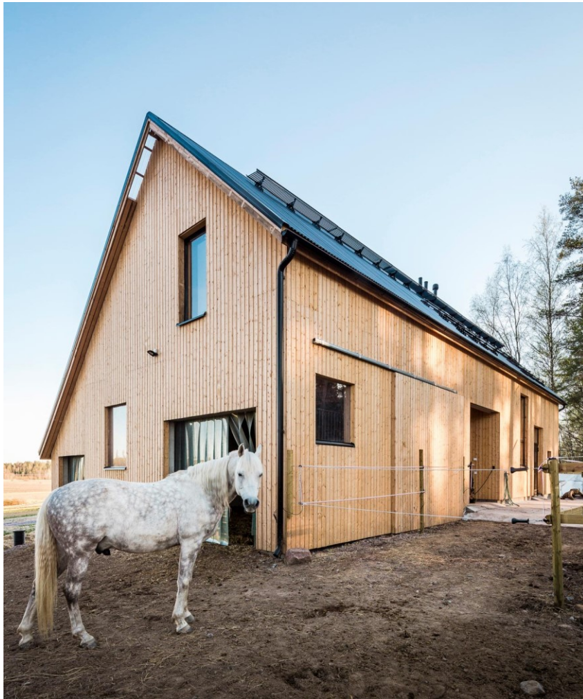
Kuva 45. Hevostalli ja pihatto Kekkapää ulkoa (POOK Arkkitehtitoimisto Oy).
