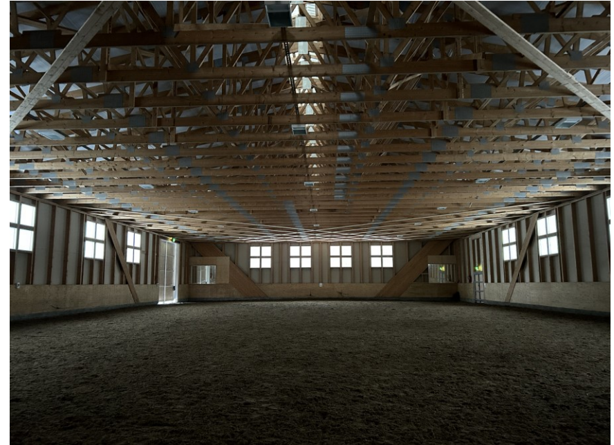
Kuva 14. Maneesissa on puinen kattorakenne ja auringonvaloa tuova kattolyhty, josta ilma poistuu painovoimaisesti.
