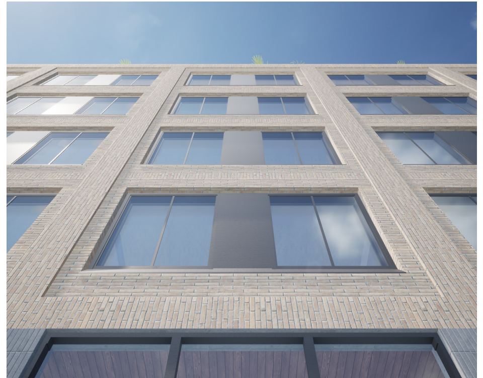
Kuva 40: Julkisivun erilaiset tiililadonnat korostavat ja rytmittävät ikkuna-aukotusta
