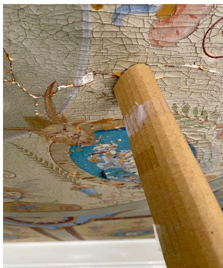
Kuva 26. Tukiessa liimattavat pinnat tarttuivat hyvin paikoilleen (Viitaniemi 2023).
