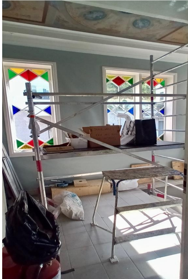
Kuva 23. Teline sijoitettiin osittain portaikkoon (Viitaniemi 2023).
