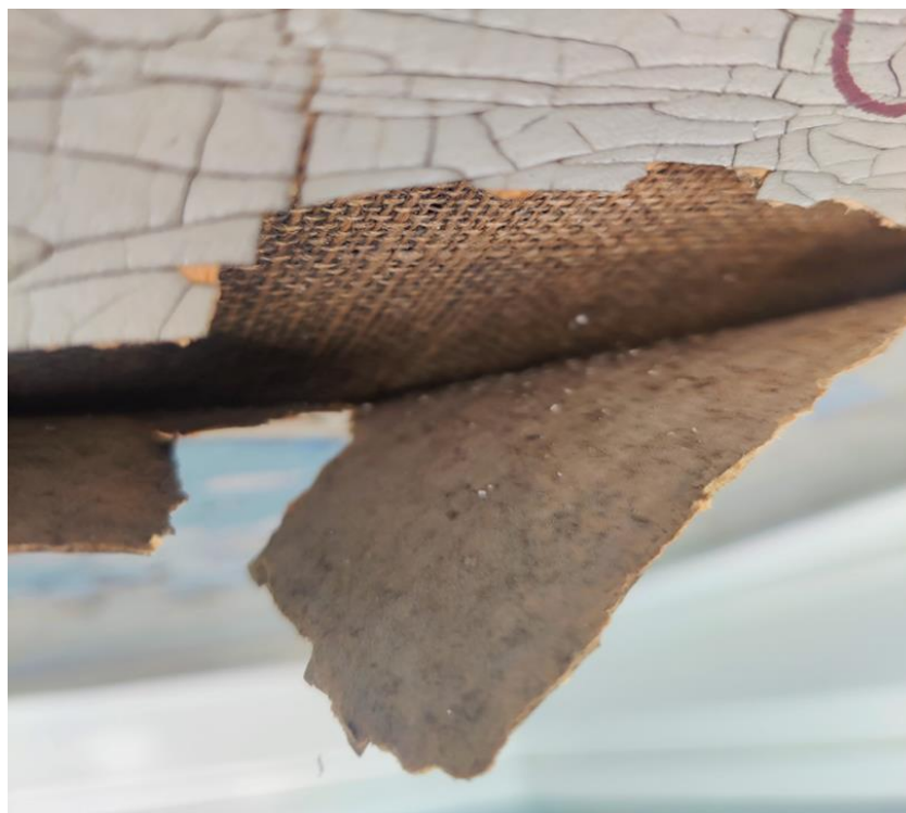
Kuva 16. Lähikuva irti repsottavasta maalipinnasta (Viitaniemi 2023).
