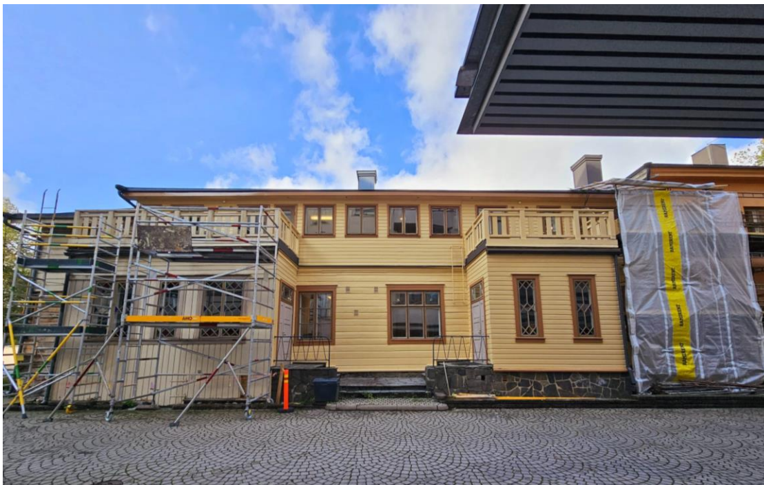
Kuva 33. Koristemaalauksessa sijaitsee vasemmanpuoleisessa, telineiden ympäröimässä porstuassa, jonka korjaustyöt ovat kuvanottohetkellä vielä kesken (Viitaniemi 2023).
