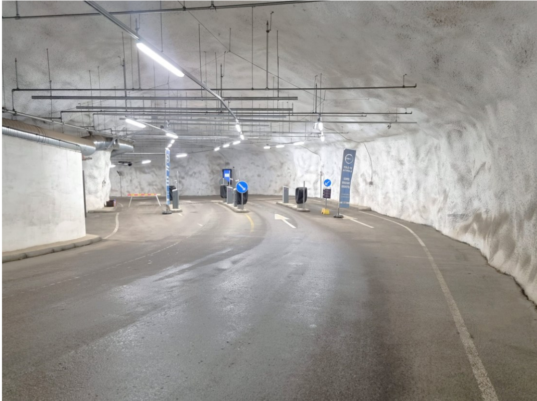
Kuva 7. Kuva pysäköintilaitoksen sisältä (Lisätietoa).
