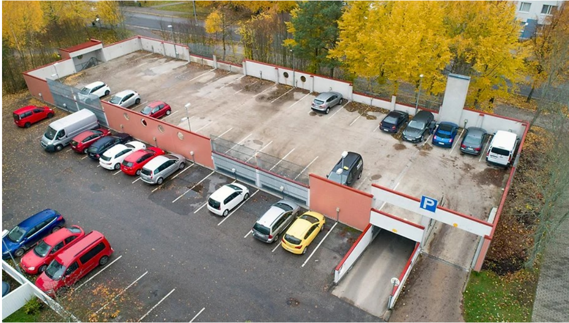
Kuva 9. Kuva pysäköinnin järjestämisestä pysäköintikannella (Helsinki, Havukuja 1, pysäköintikansi ja -halli).
