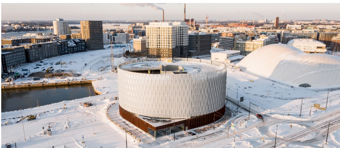
Kuva 5. Royal Park pysäköintilaitos (Royal Park, Helsinki).
