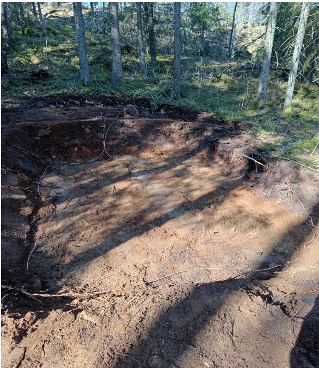
Kuva 6. Perustusmaadoituselektrodi levitettynä kaivannon pohjalle.
