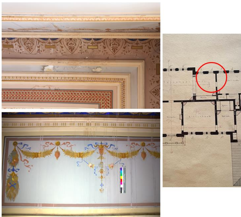
Kuva 28: Kuvakollaasi luoteisen puolen seinältä (2024)
