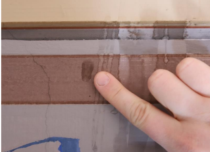
Kuva 34. Kosteus testi maalipinnalle (2024)
