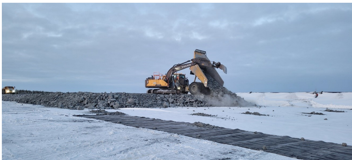
Kuva 3. Louhepadon kerroksittaista rakentamista. Kuvassa rakennetaan ensimmäistä kerrosta.
