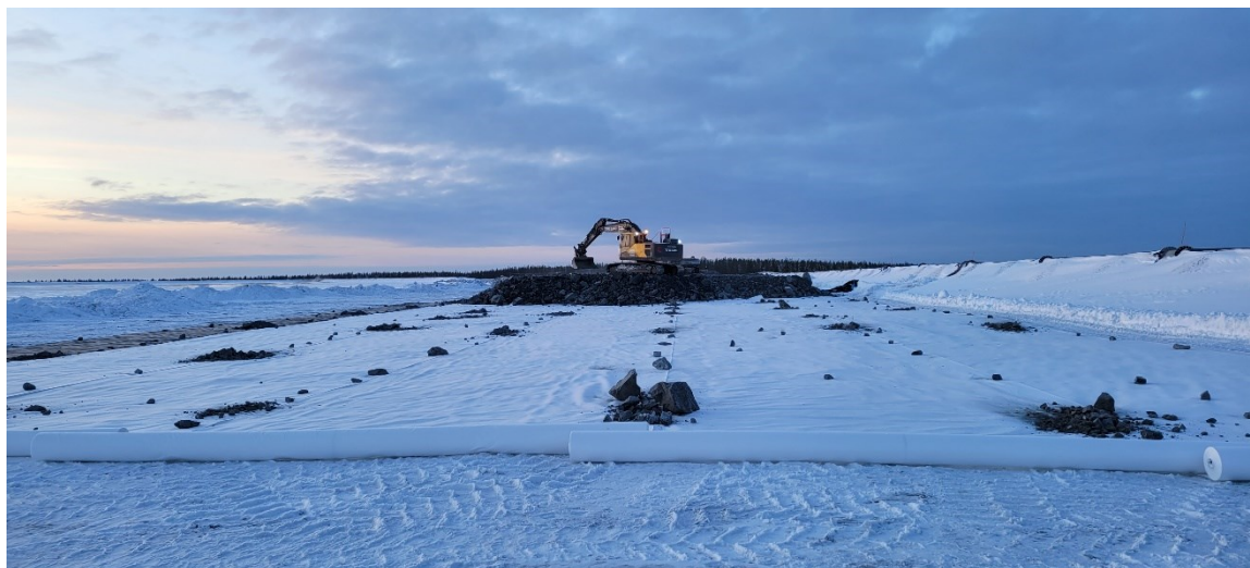
Kuva 2. Tasattua rakennuspohjaa, jossa suodatinkangas on levitetty.
