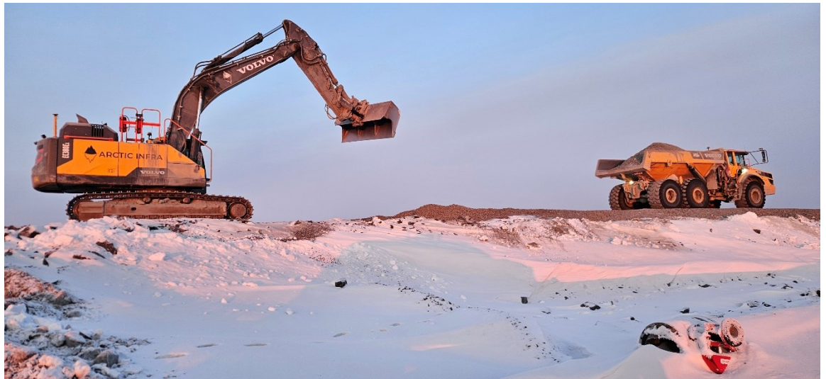
Kuva 7. Kantavan kerroksen tekoa valmiin patopenkereen pinnalle.
