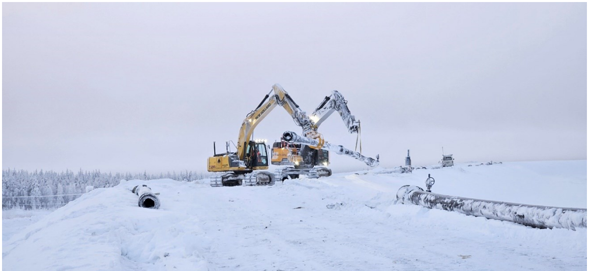
Kuva 9. Rikastushiekan siirtolinjan siirtoa koneellisesti uuden patopenkerein päälle.
