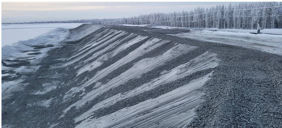
Kuva 5. Ohjeiden mukaisesti levitettyä ja painotettua suodatinkangasta altaan sisäpuolen luiskassa.
