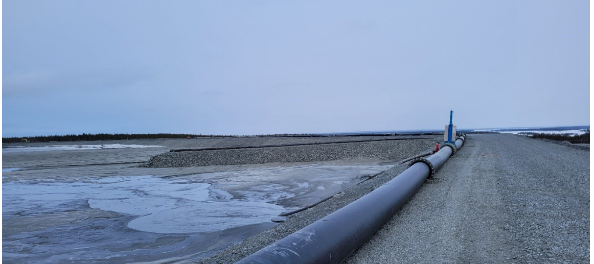
Kuva 8. Siirretty putkilinja uuden padon harjalla altaan puoleisessa laidassa. Venttiilit ja spigotti- putket asennettuina.
